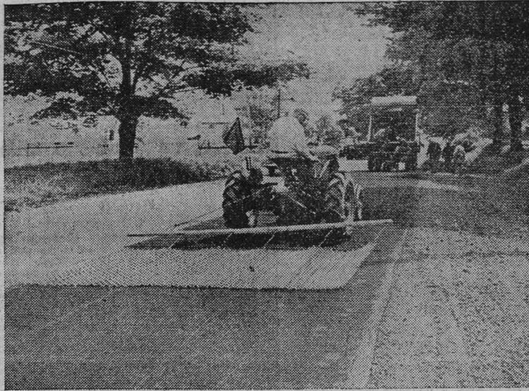
En los Estados Unidos se ha empezado a ensayar un nuevo pavimento para carreteras a base de caucho pulverizado y arena, que se aplica sobre el asfalto y evita patinazos. En la fotografía se ve un aspecto de la aplicación del nuevo pavimento.
