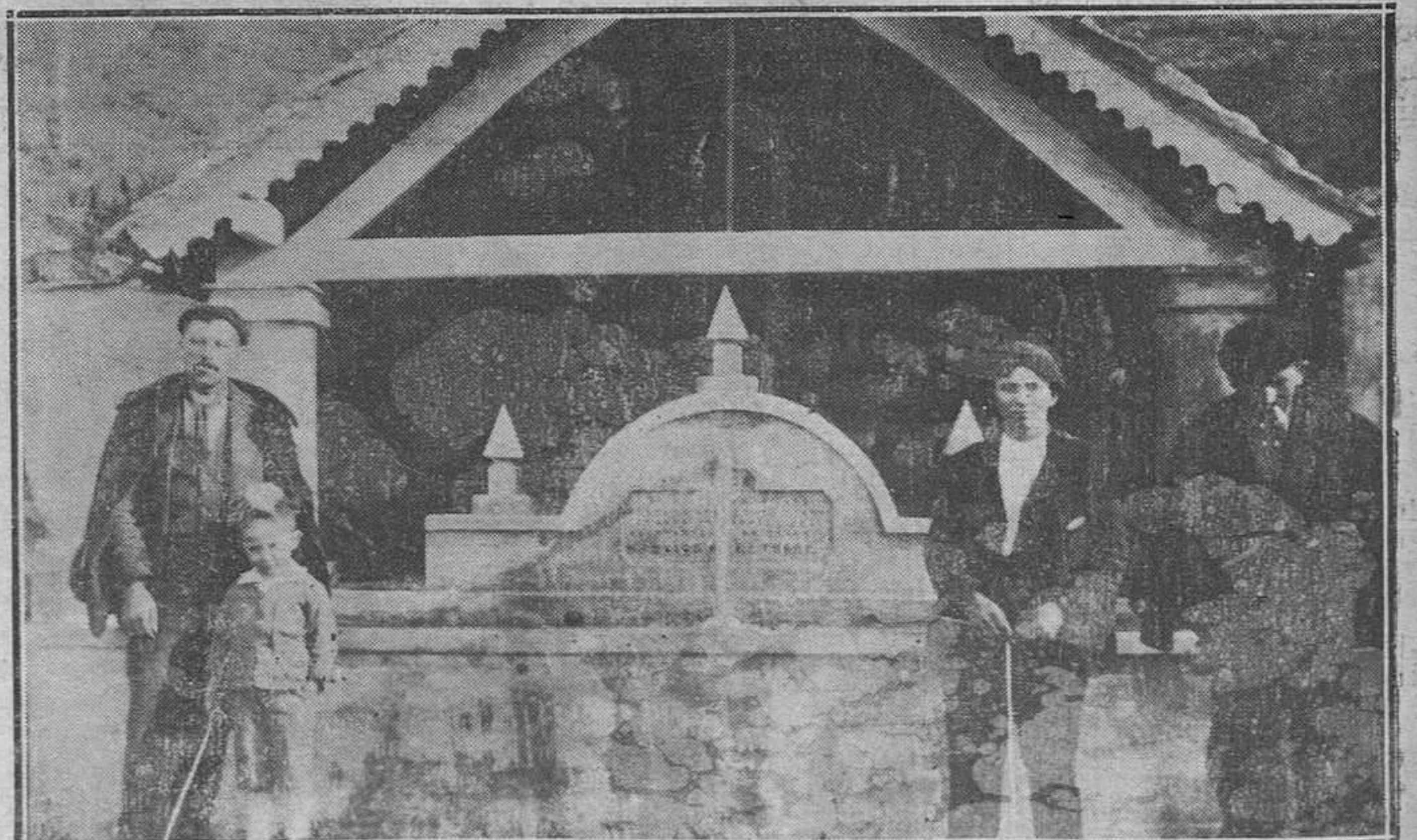
FONDAL (TINEO).—Hermoso lavadero construido en este pueblo, cuyo frente es de cinco metros por seis de fondo, con capacidad para ocho personas, en lavaderos individuales.
