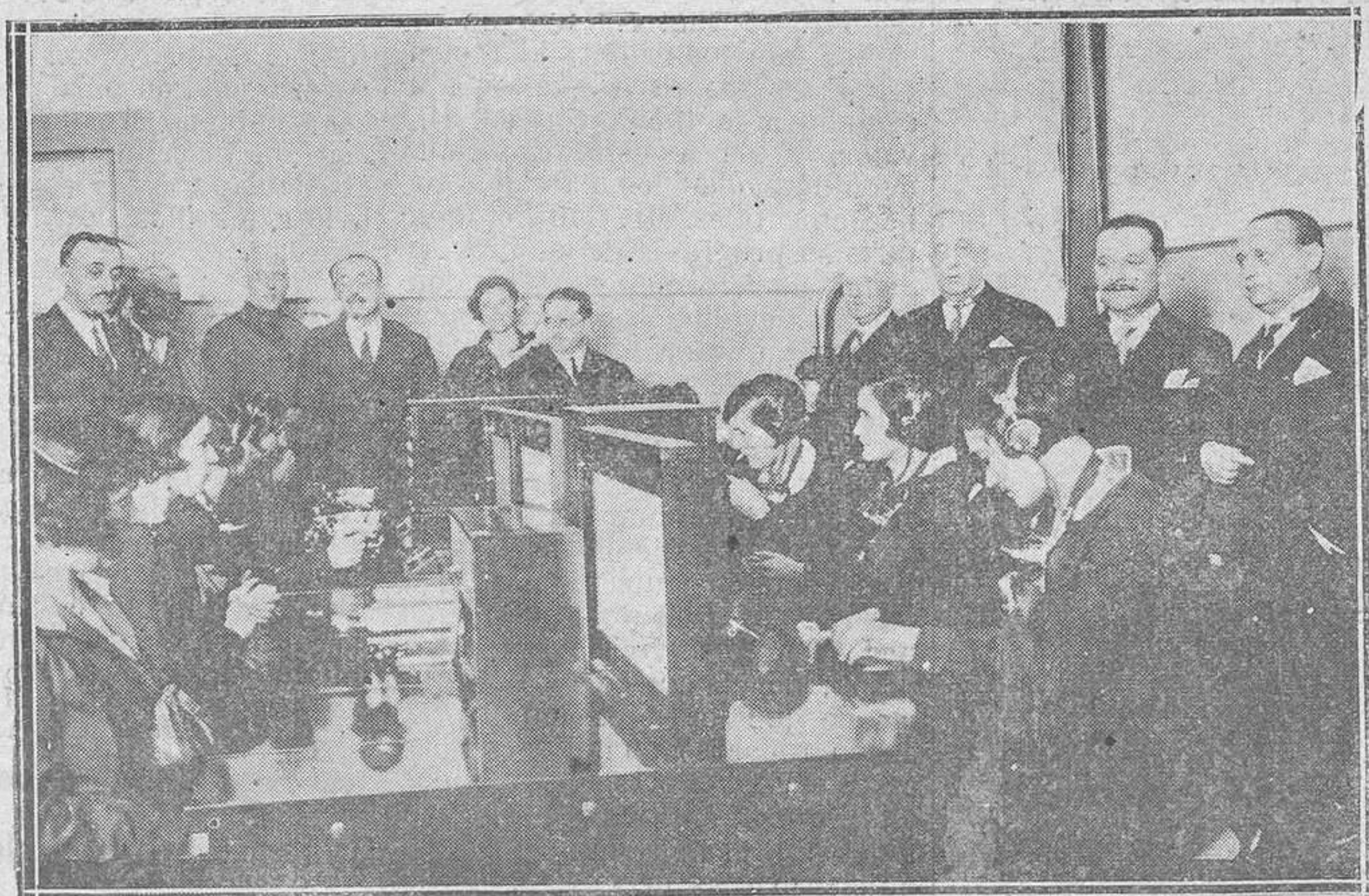
OVIEDO. — Las autoridades visitando la dependencia destinada a transmisión de teléfono. (Foto Mena)
