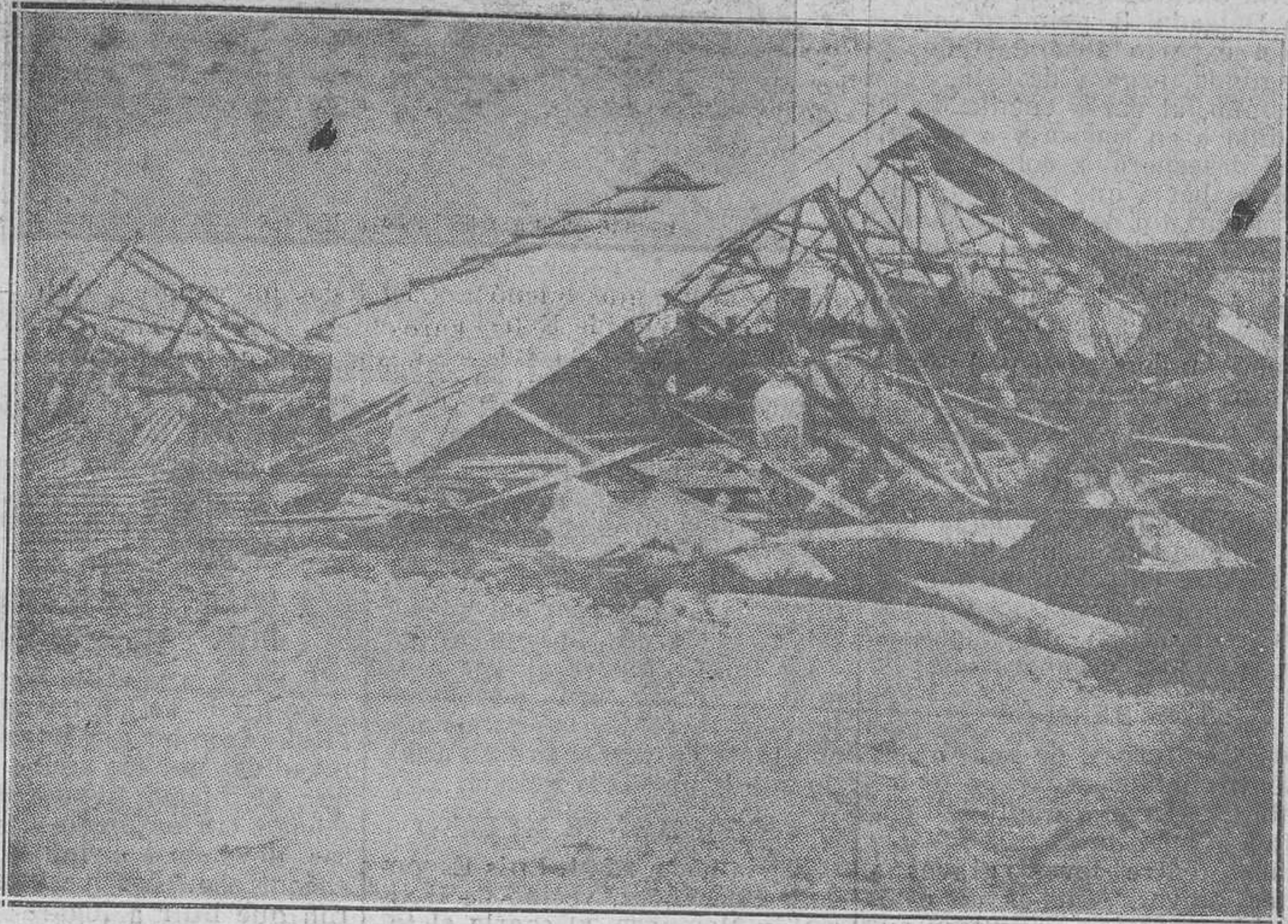
GUANAJAY: DESPUES DE LA CATASTROFE.-Restos de la Fundición del señor Zayas, arrasada totalmente por el ciclón.
