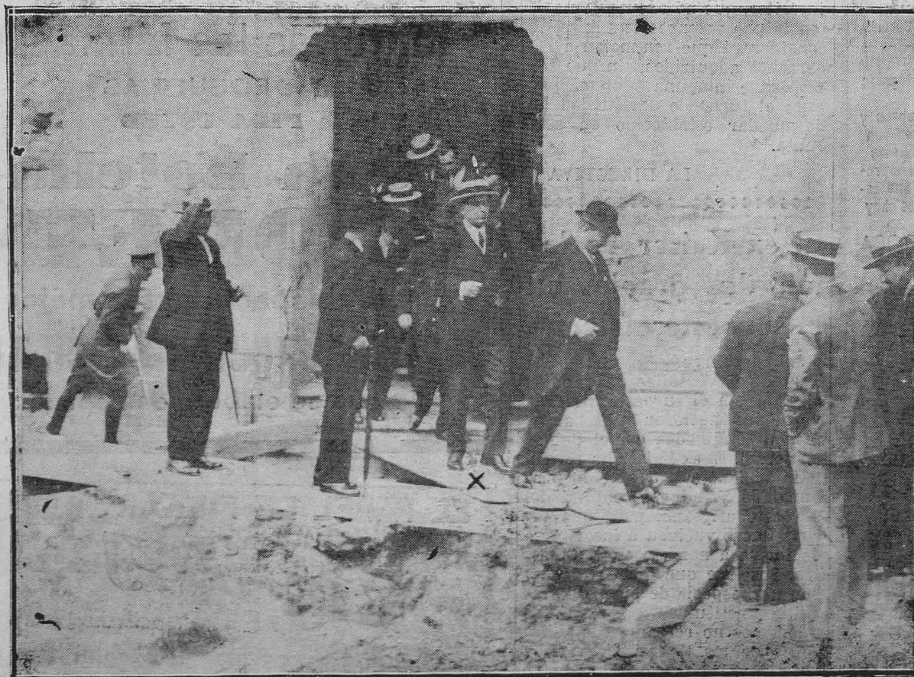
OVIEDO.—El ministro de Hacienda (x) visitando las obras de la nueva casa de correos. Foto Mena
