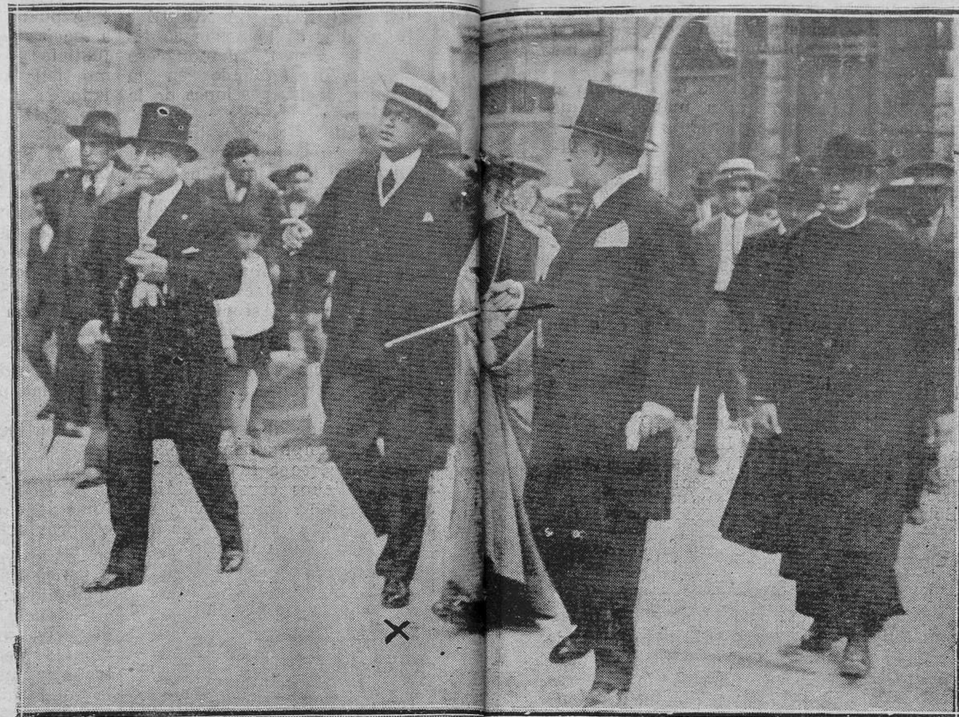
OVIEDO.—El ministro de Hacienda (x) visitando las obras de la nueva casa de correos. Foto Mena
