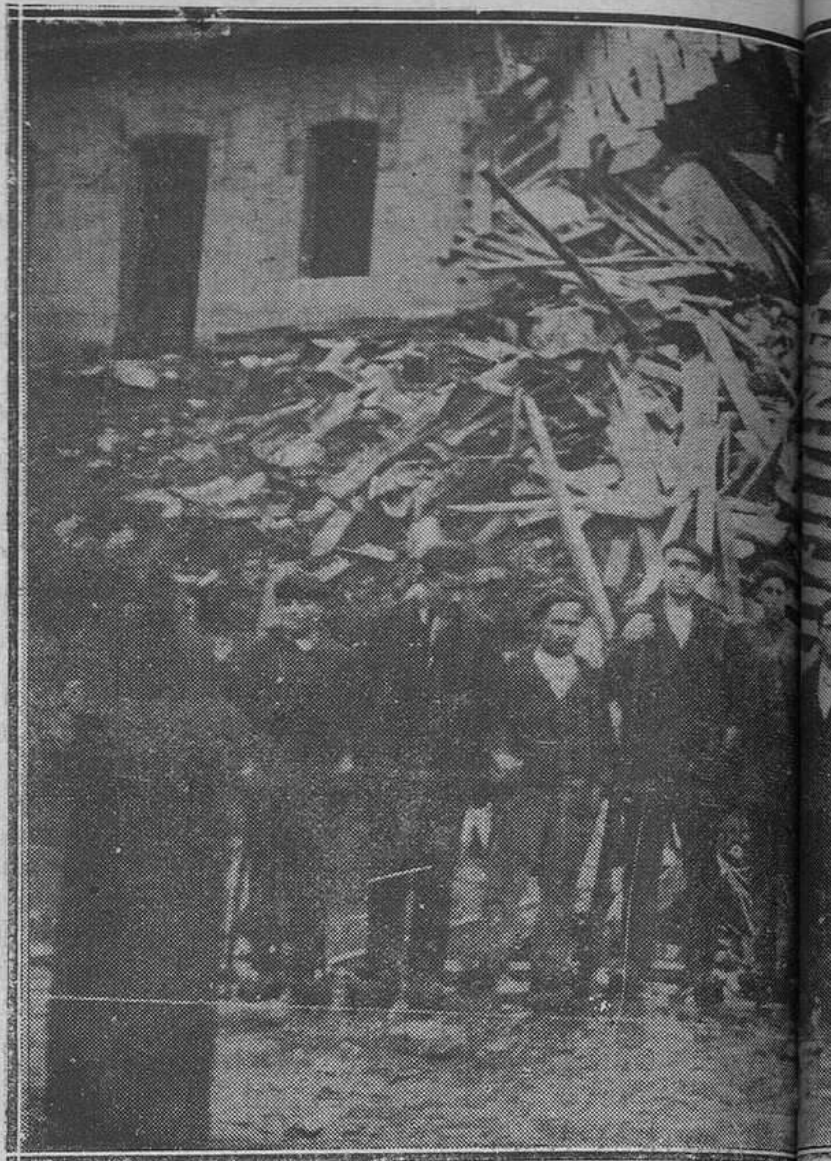
Ujo.-A causa de un desprendimiento de tierras se hundió un edificio. Los moradores buscan inútilmente, entre los escombros, los restos de su pobre ajuar, que la violencia del golpe convirtió en cascote inservible.
