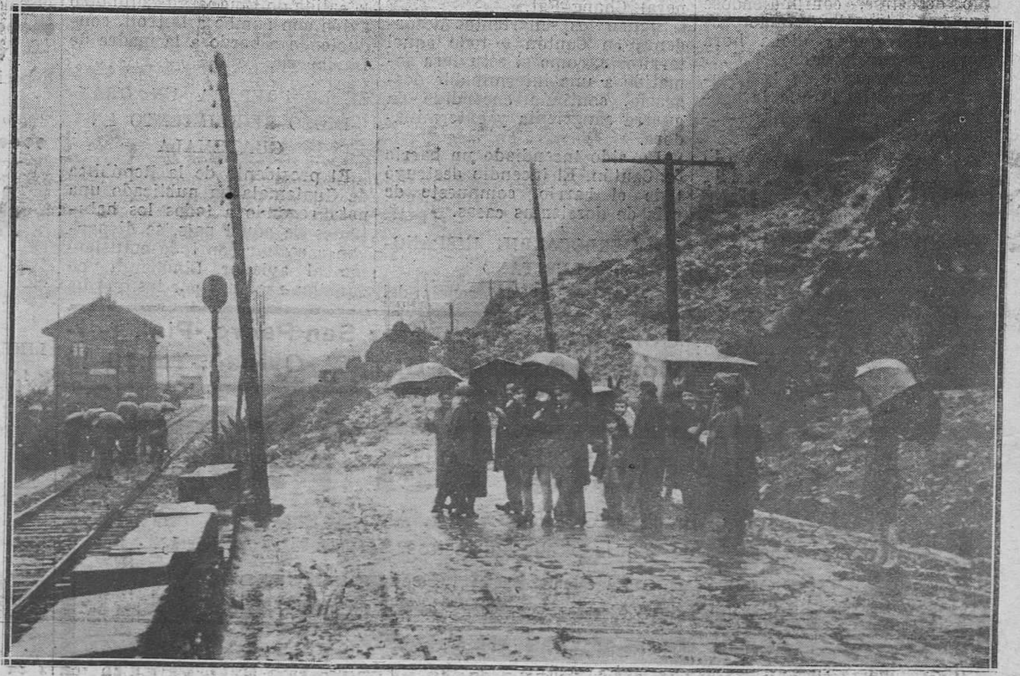
Ujo.-La carretera de Gijón a Madrid, interceptada por el hundimiento de ayer, frente al apedregado de Reicastro. (Meno)
