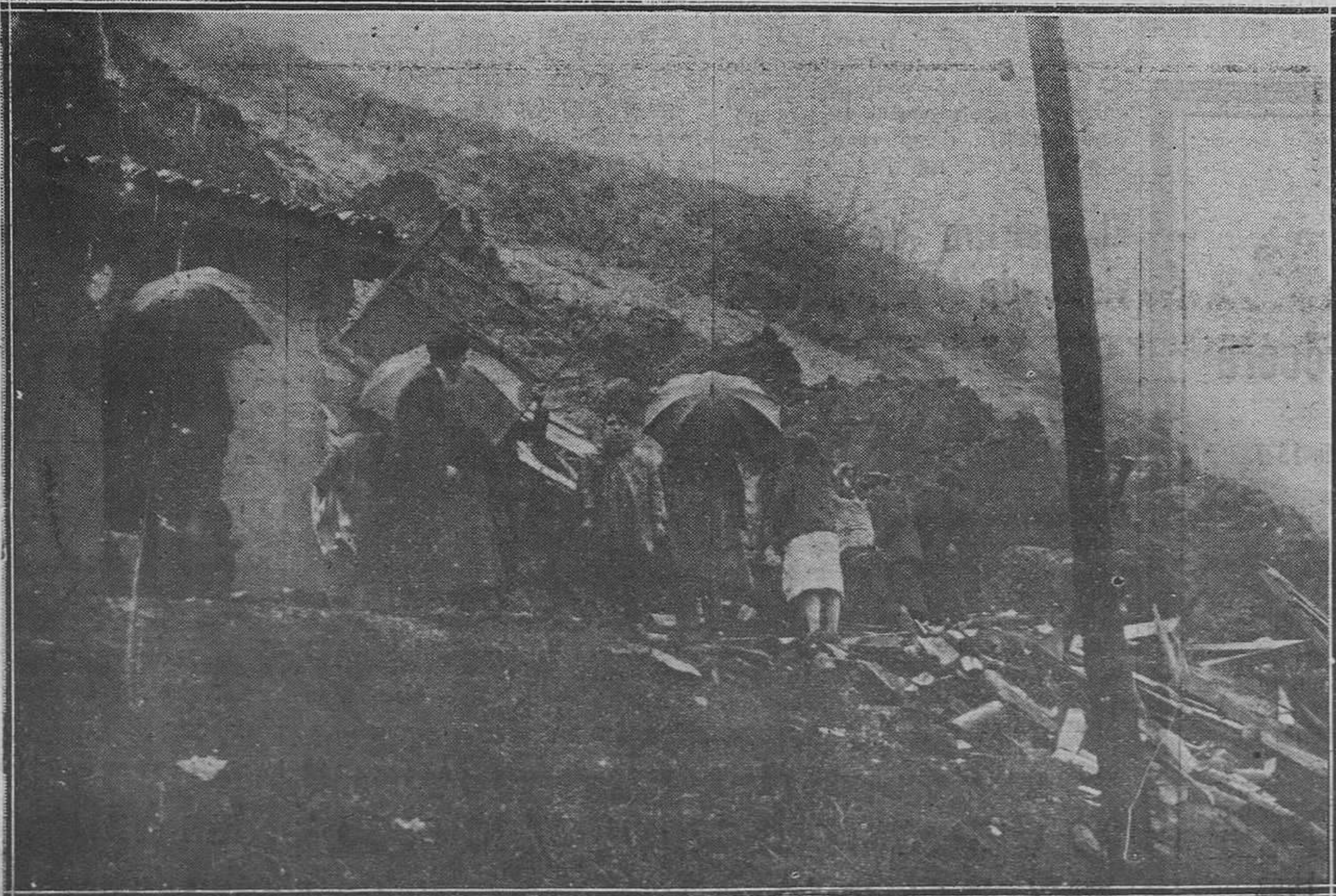
Ujo.-Los moradores de las casas hundidas en Reicastro, buscan inútilmente, entre los escombros, los restos de su pobre ajuar, que la violencia del golpe convirtió en cascote inservible. (Foto Mena)
