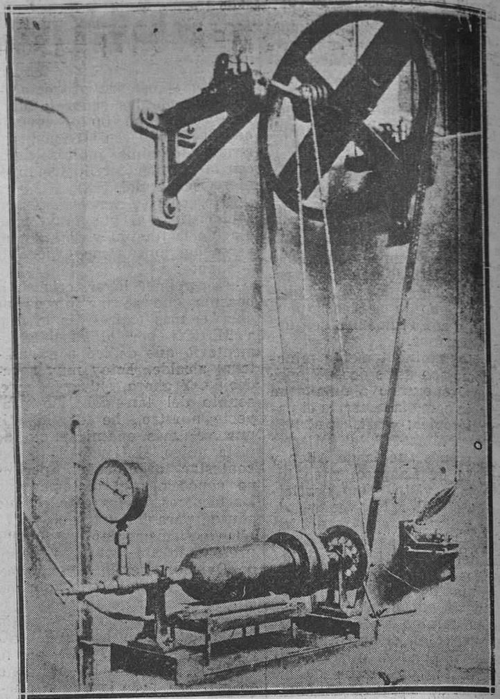
Bomba para la transformación del carbón en petróleo.
