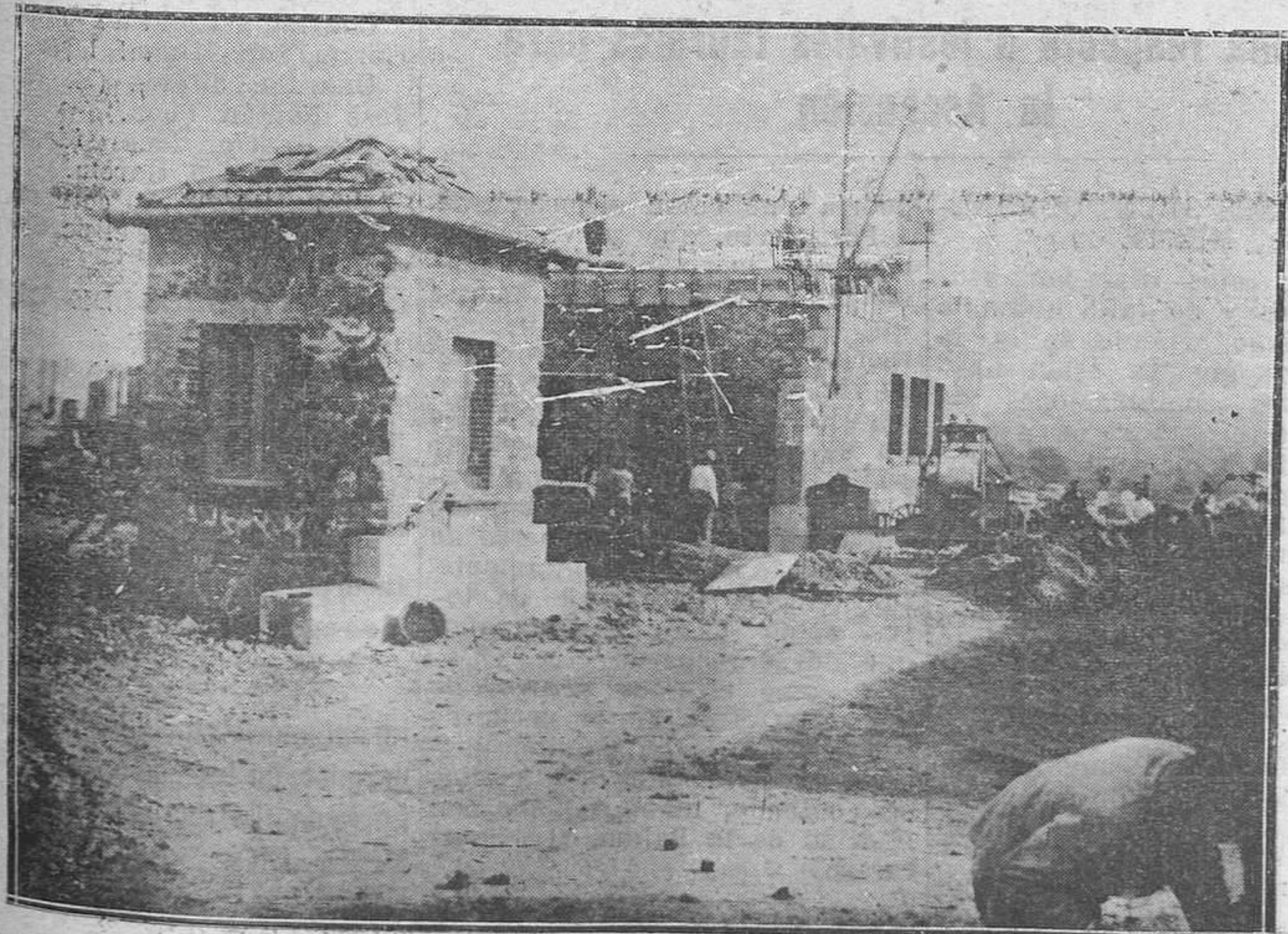
Oviedo.—Un aspecto de las obras del nuevo Matadero.
