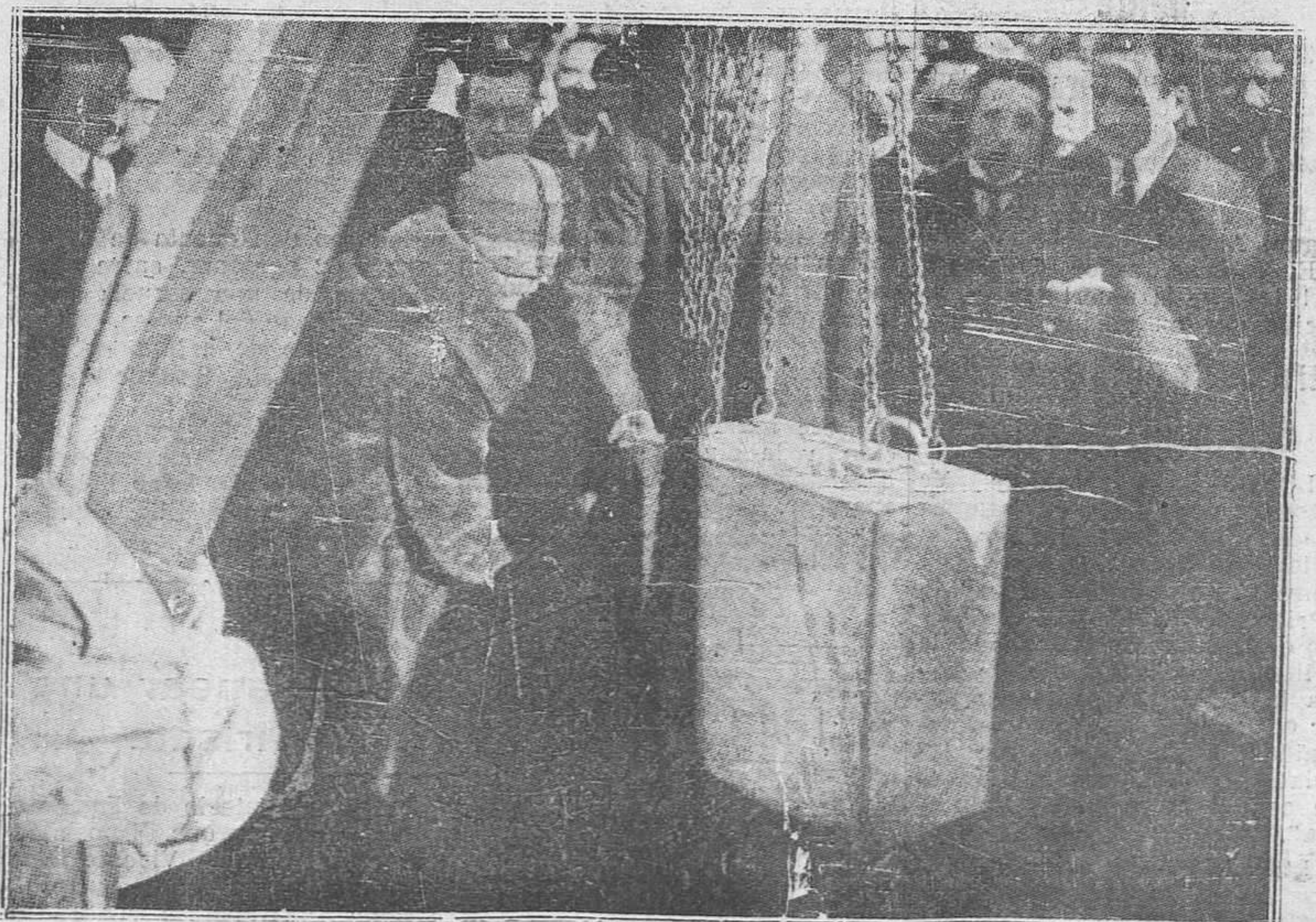
Buenos Aires. -Momento de la colocación de la primera piedra para el futuro palacio del Centro Asturiano.
