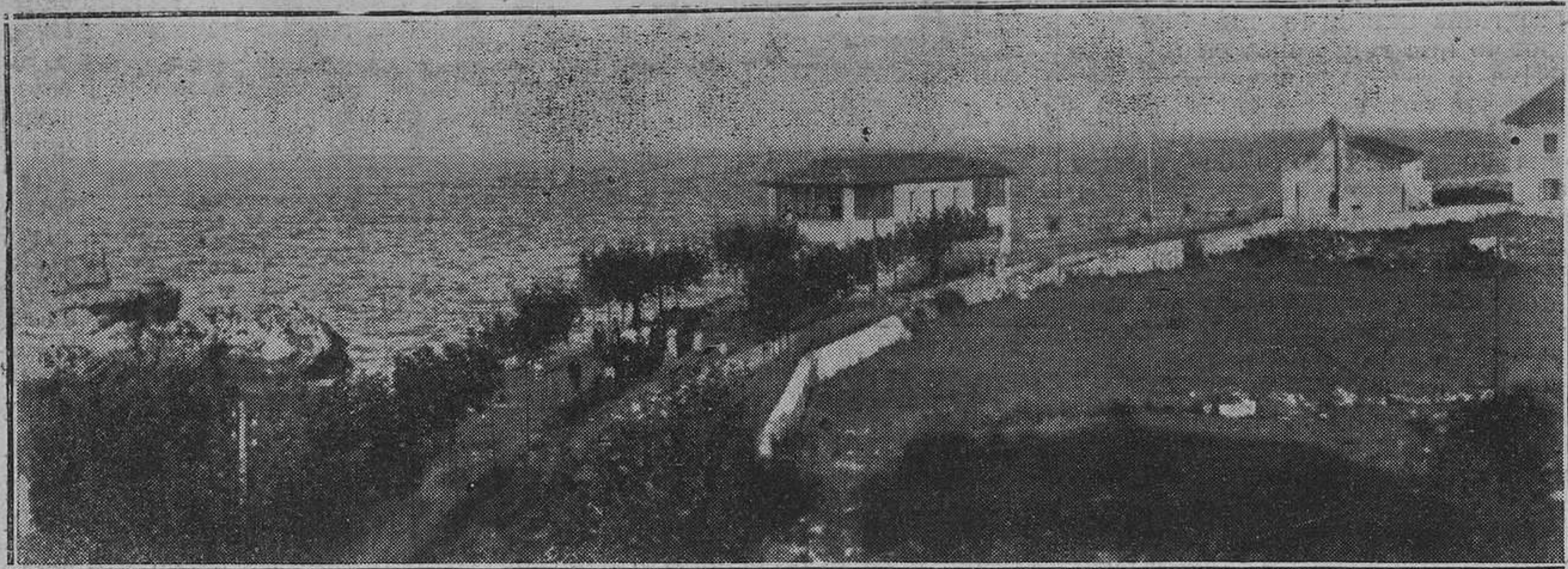
ASPECTOS DE LLANES.—LA CASETA DEL SALVAMENTO DE NAUFRAGOS; LLAMADA "LA TIJERINA" (Foto M. T.)
