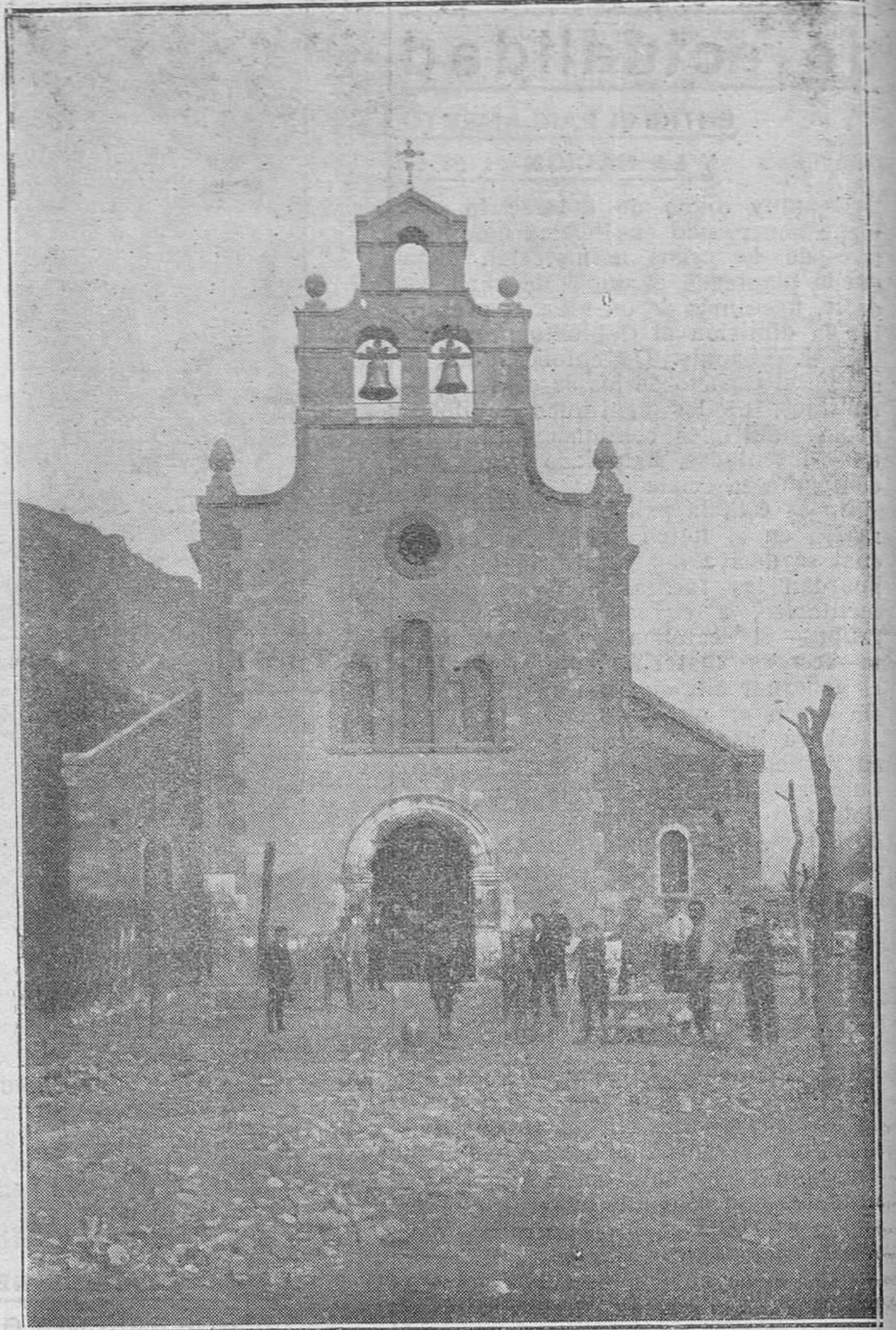
SANTA CRUZ DE MIERES.—Fachada principal de la Iglesia recién inaugurada. (Foto Foro)
