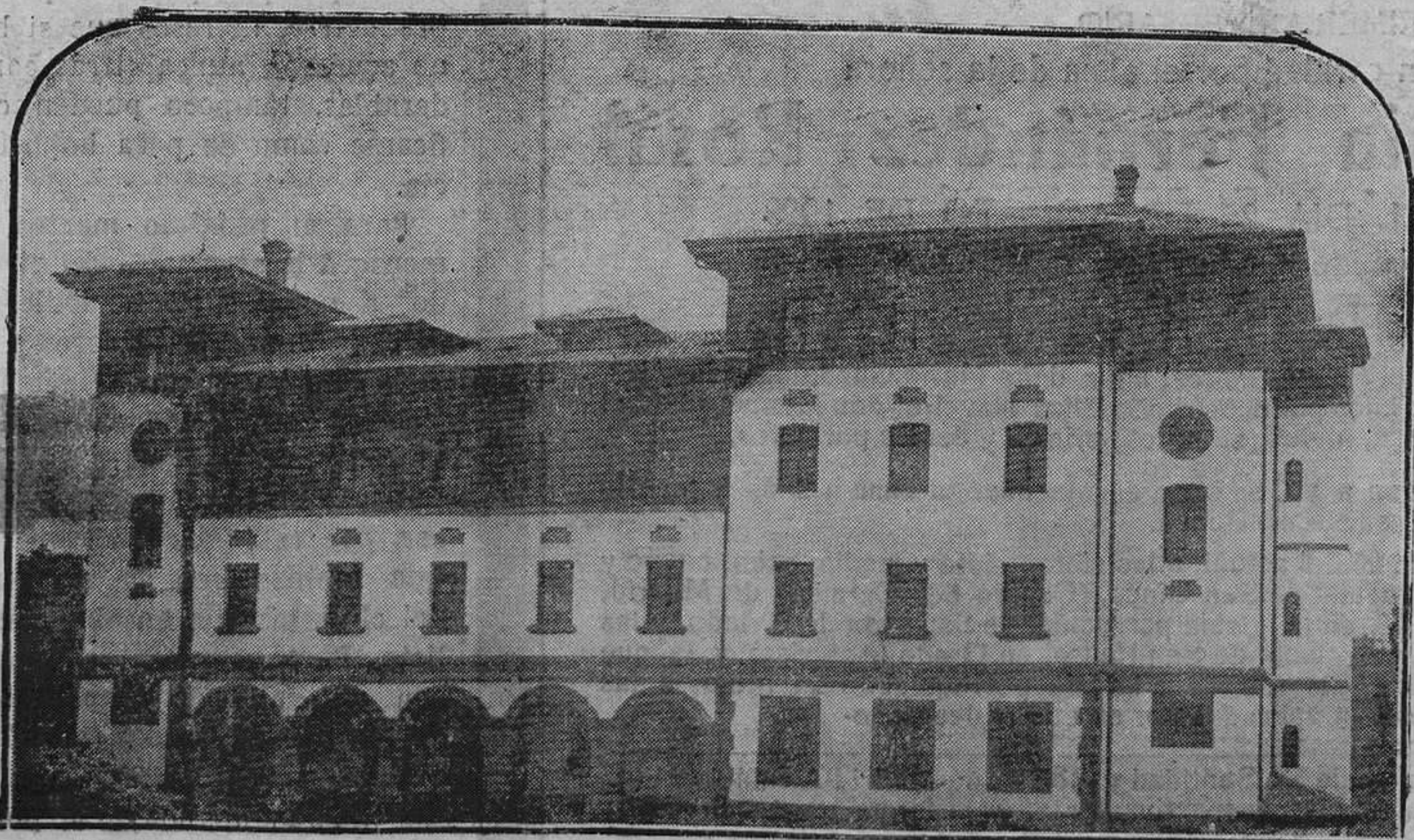
OVIEDO.— Fachada principal de la Casa de Caridad de San Lázaro, de cuyos planos es autor el señor Bobes (Foto Mena)
