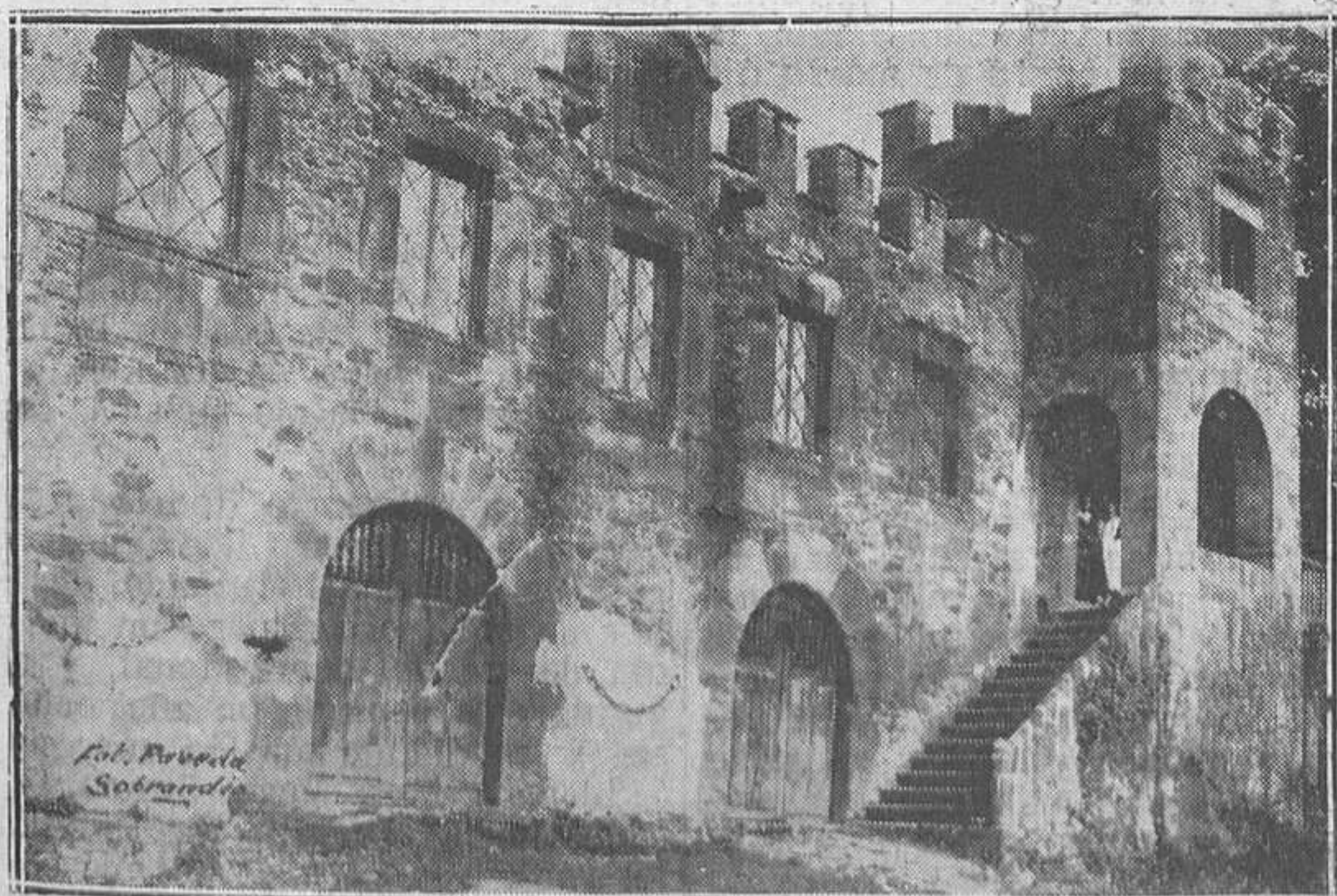
El castillo de la Cabezada, en Blimea, con las dueñas en la escalera de honor a la torre del homenaje. (Foto Canteli)
