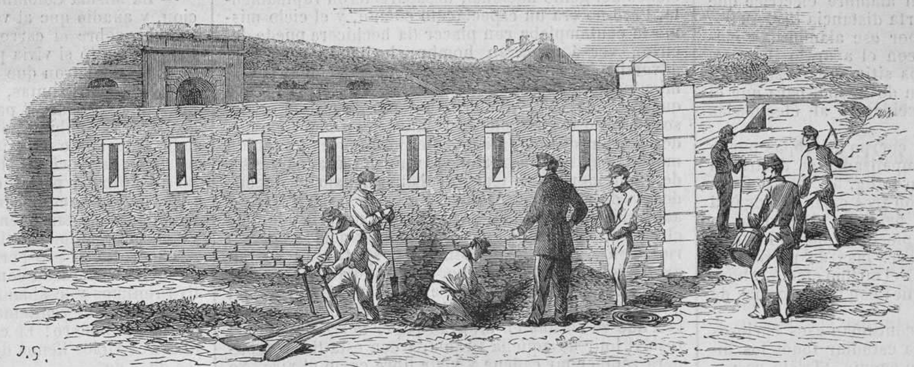
Colocacion de un cartucho de dinamita al pié de una pared de fábrica.
