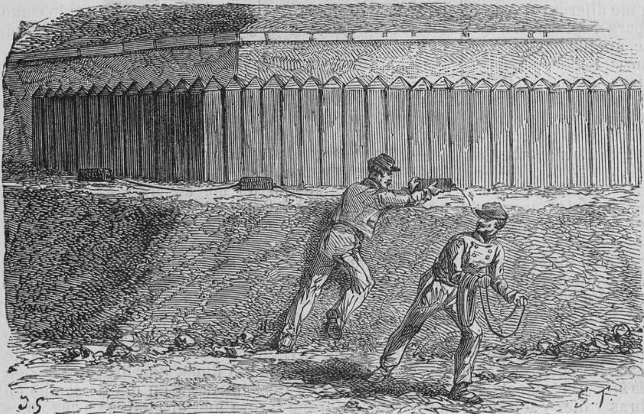
Antes de la explosion.
