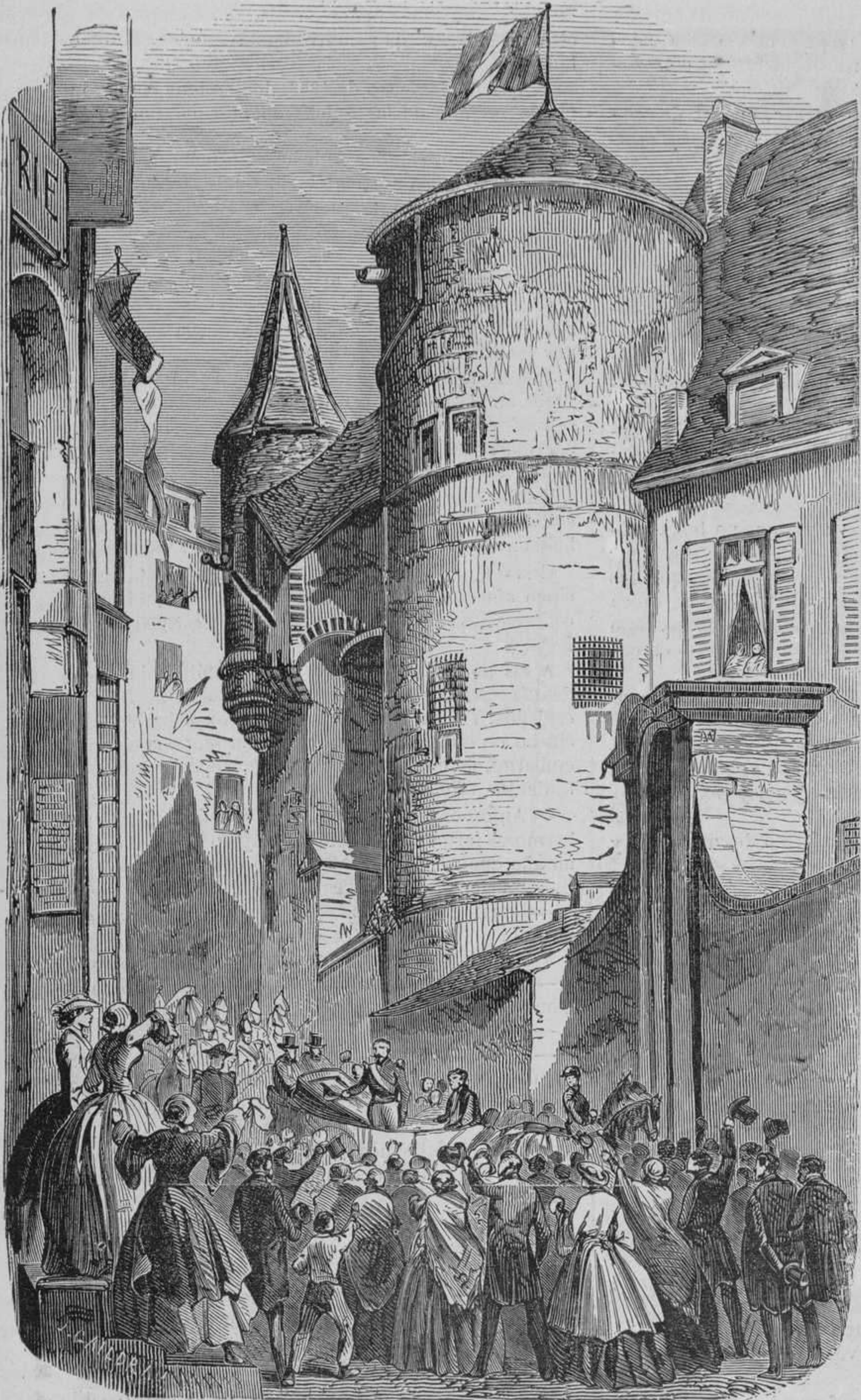
LLEGADA DE SS. MM. A LA PREFECTURA DE GRENoble.
