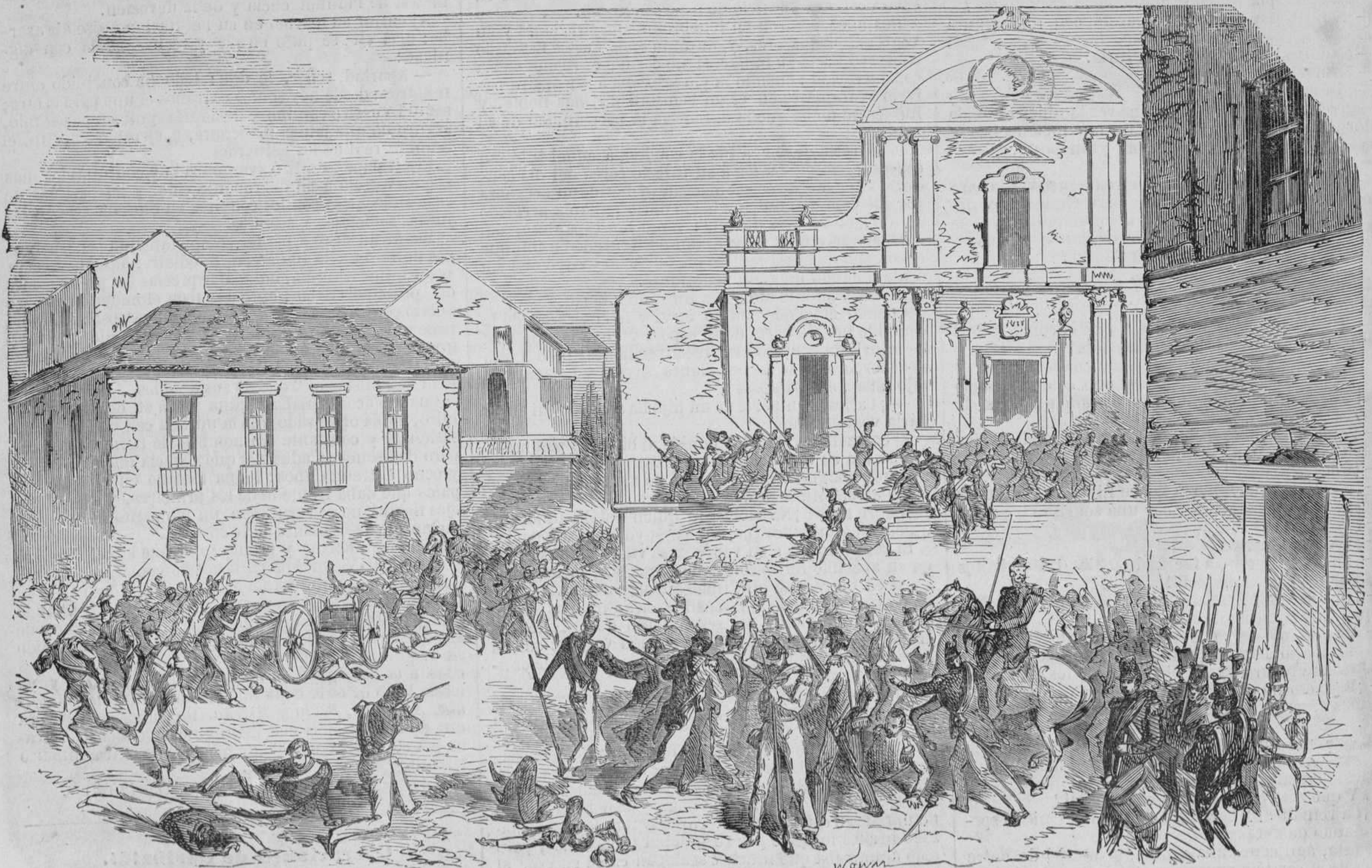
OCUPACION DE LA PLAZA DE LA IGLESIA EN REGGIO, EN CALABRIA.
