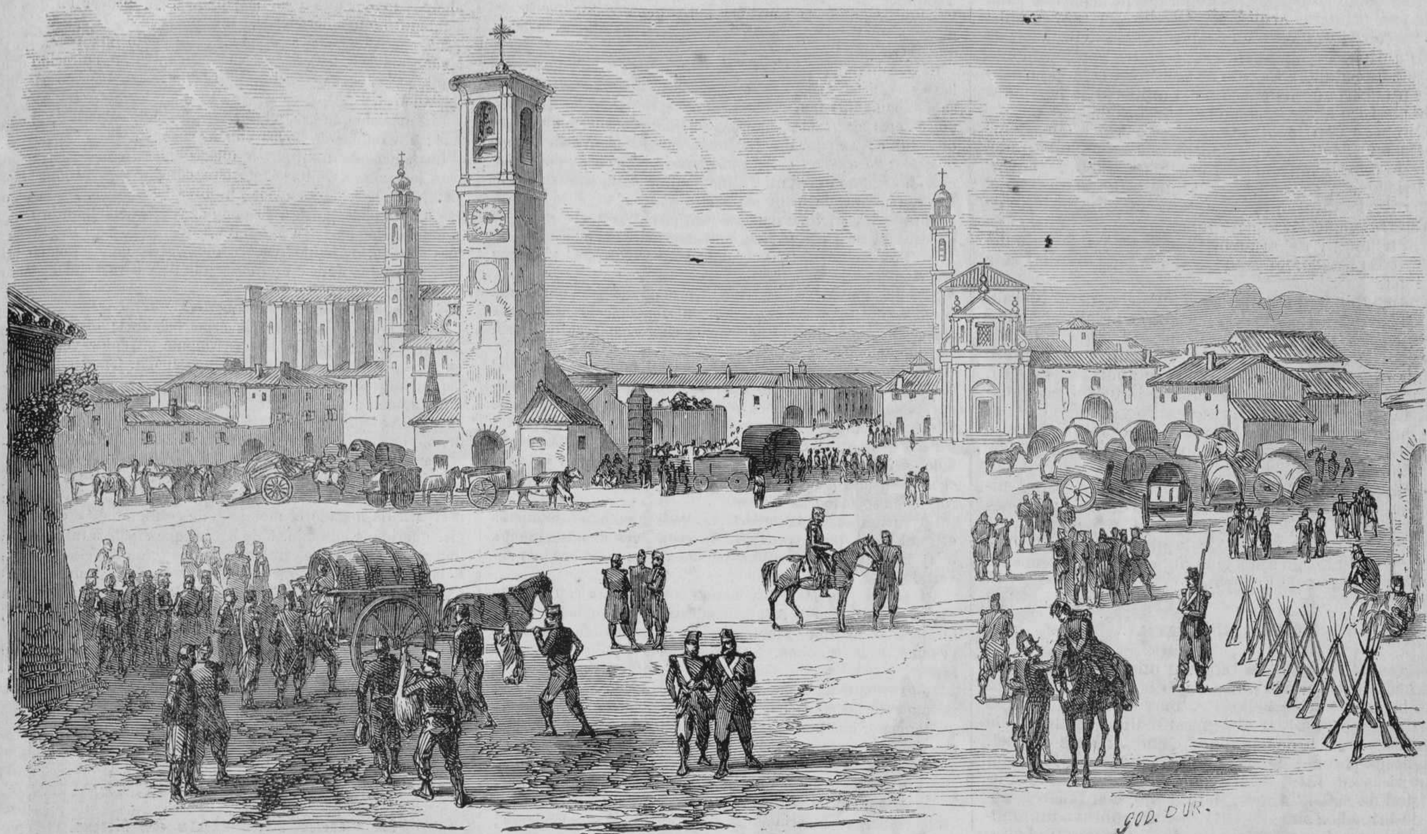
CAMPAMENTO DE TROPAS FRANCESAS EN LA PLAZA MAYOR DE TRAVIGLIATO.
