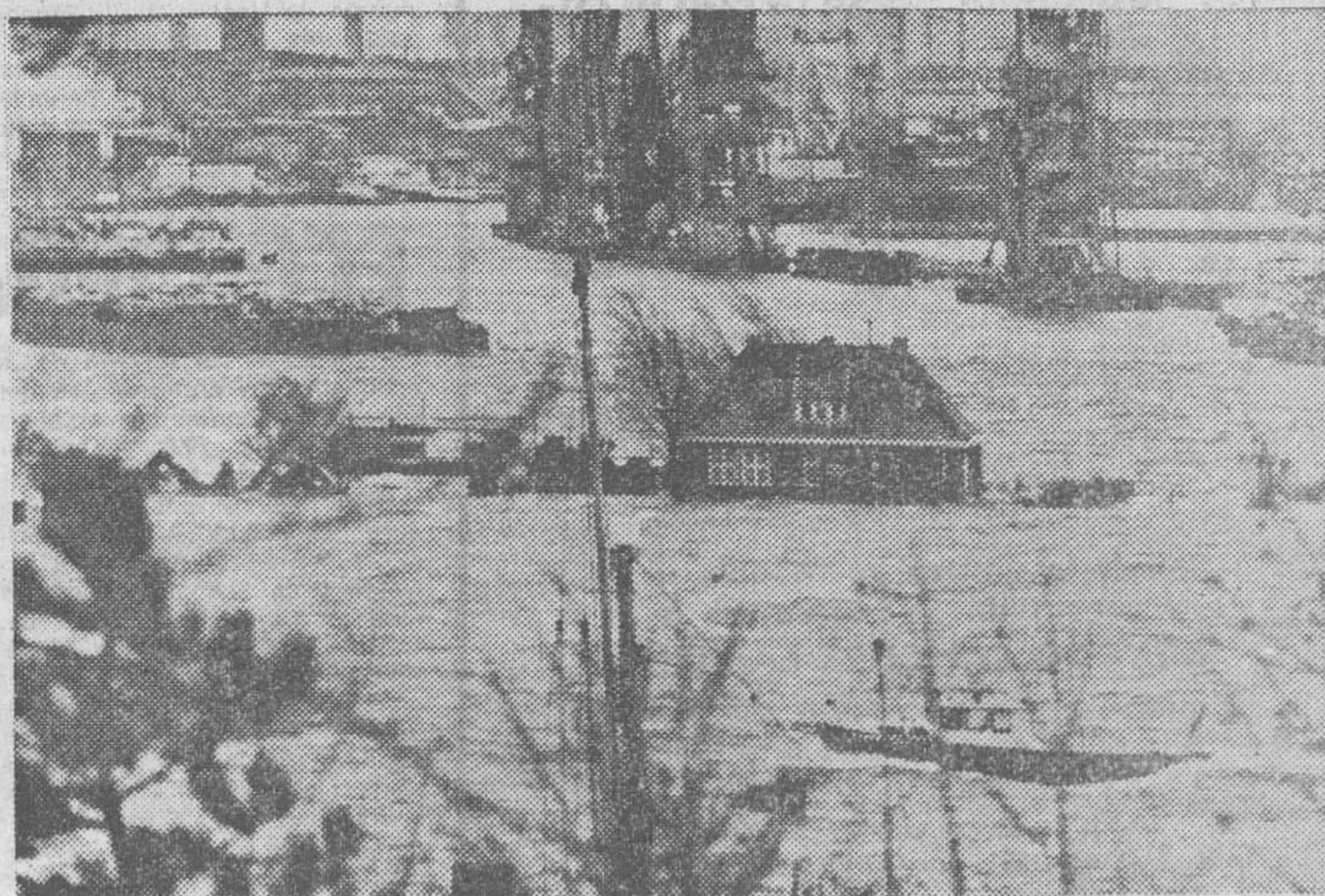
Hamburgo. — Las fuertes tormentas causaron grandes inundaciones por el desbordamiento del río Elba a su paso por esta ciudad alemana. En la foto podemos ver una casa que, normalmente, se halla entre el río y el muelle portuario. — (Foto Europa Press)
