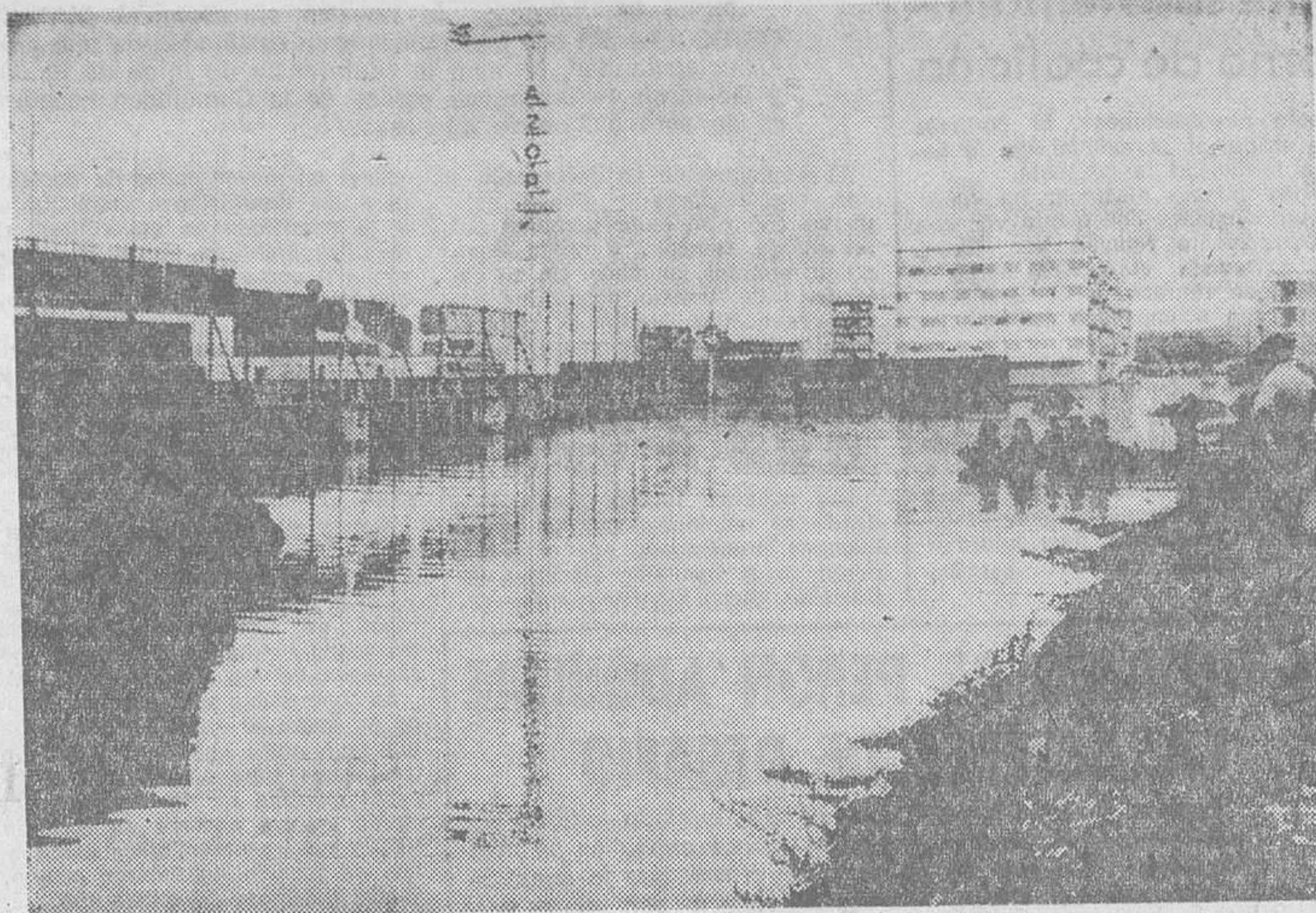
Cartagena. — Un aspecto de El Almarjal, barrio contiguo al estadio municipal del C. D. Cartagena, inundado tras las recientes lluvias torrenciales. Muchos de los vecinos del barrio hubieron de utilizar lanchas neumáticas pertenecientes al Centro de Buceo de la Armada para trasladarse a sus domicilios. (Foto Cifra.)
