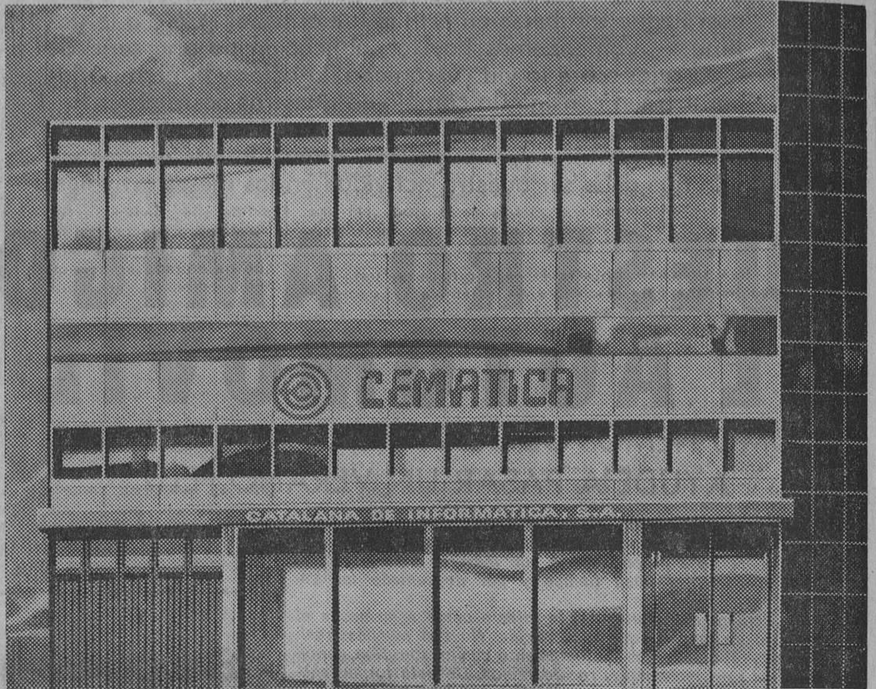
Fachada principal del edificio CEMATICA
