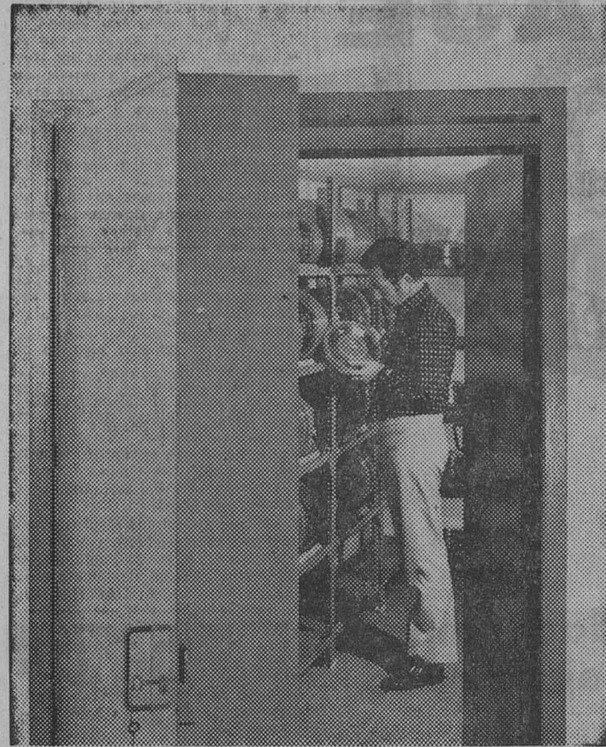
Cámara acorazada anticombustible. La información de los clientes protegida al máximo.
