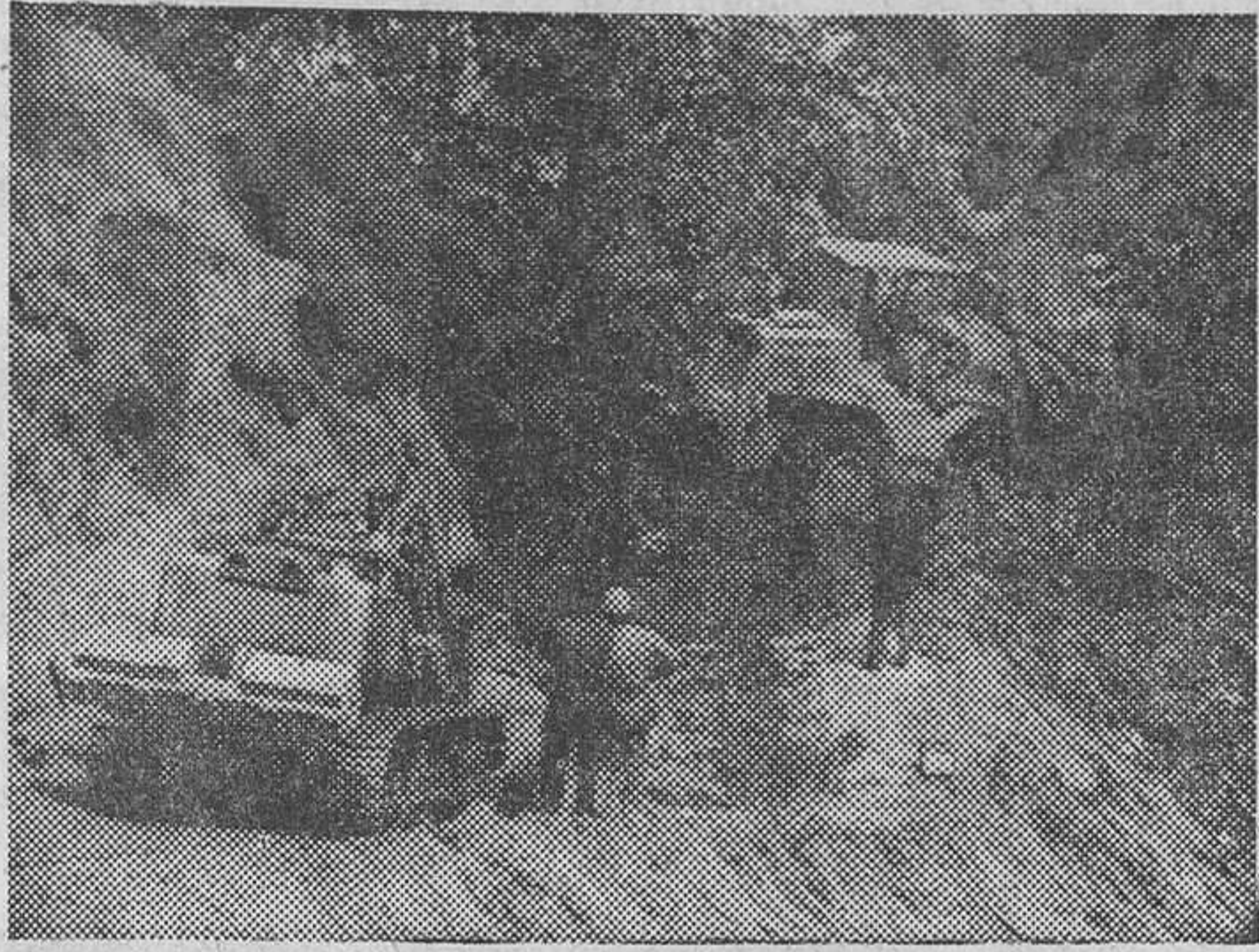
Un momento de los trabajos de desescombro durante las operaciones de búsqueda del cadáver. — (Foto Cifra.)
