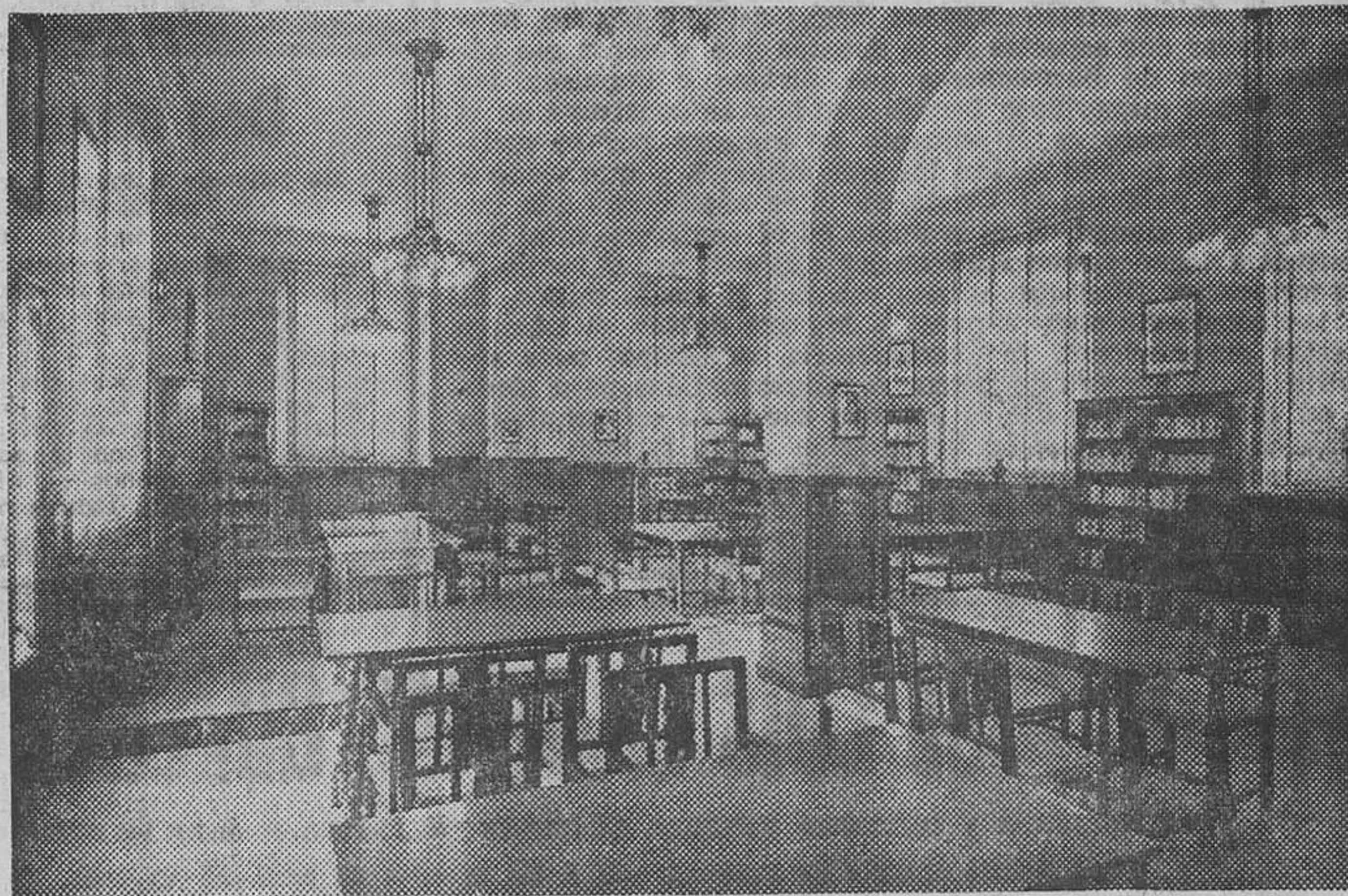
Biblioteca y Casa de cultura de Llinás del Vallés (Foto: Postius)
