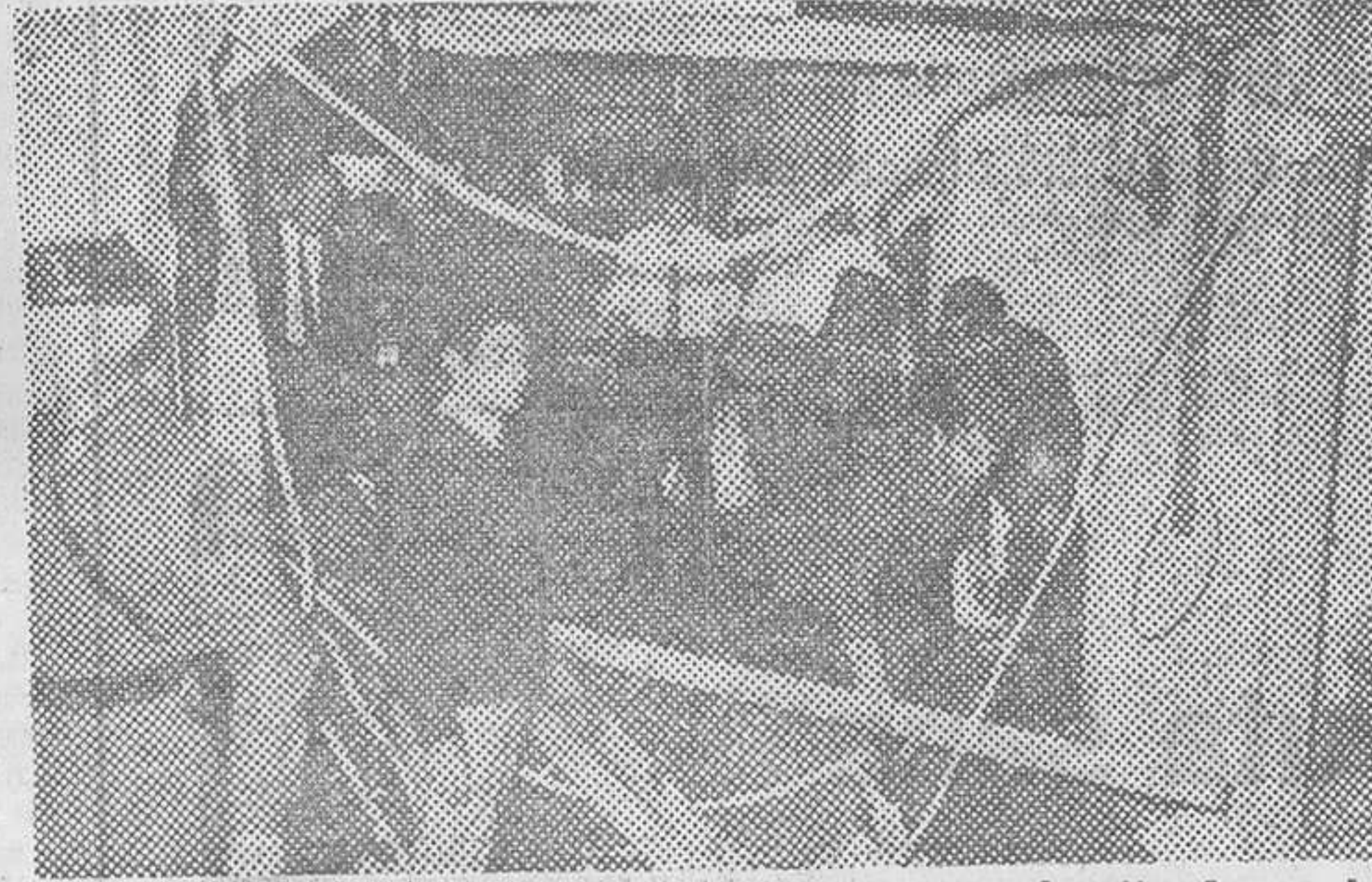
Estado en que quedó el taller de guarnicionería situado en la Rambla de Nuestra Señora, de Villafranca del Panadés, después de la explosión ocurrida, la cual sólo ocasionó los daños que pueden apreciarse en esta nota gráfica. (Foto Cifra)
