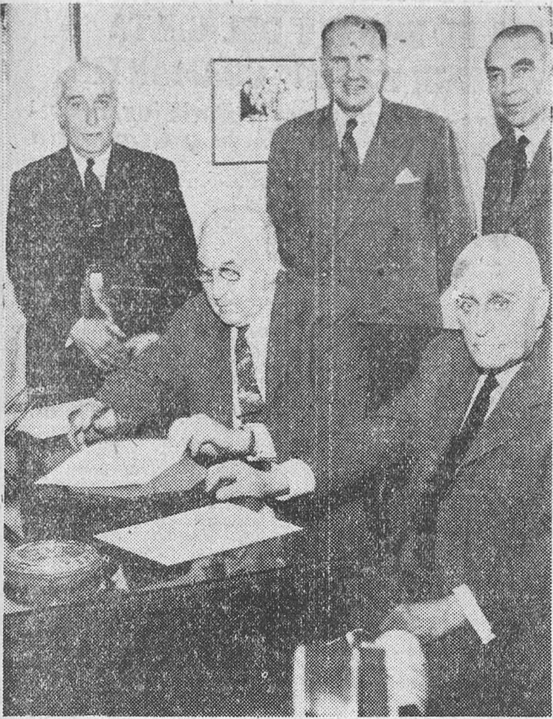
Madrid. — Un momento de la firma para la primera fase de la construcción de la Base de Torrejón de Ardoz, cuyo contrato ha sido adjudicado a la razón social barcelonesa Fomento de Obras y Construcciones. — (Foto Cifra.)
