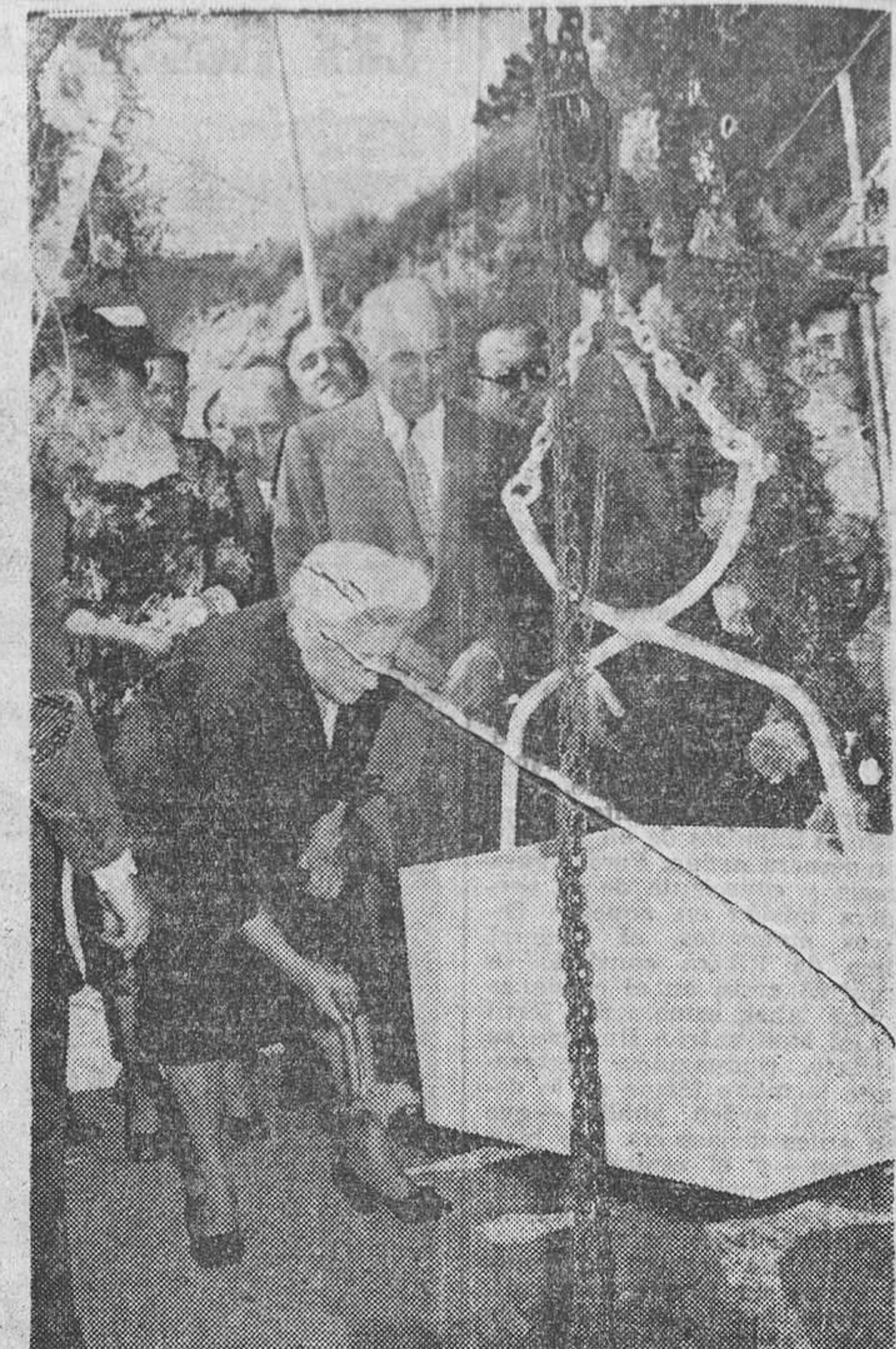
Doña Ana Gironella de Mundet, echando la primera paletada de cemento en el acto de colocación de la primera piedra de los Hogares que llevarán su nombre. — (Foto Pérez de Rozas.)
