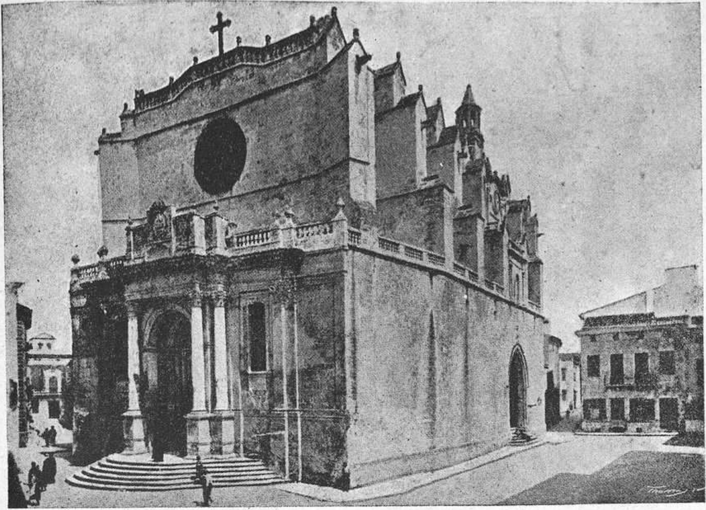
1.—VISTA EXTERIOR GENERAL.
