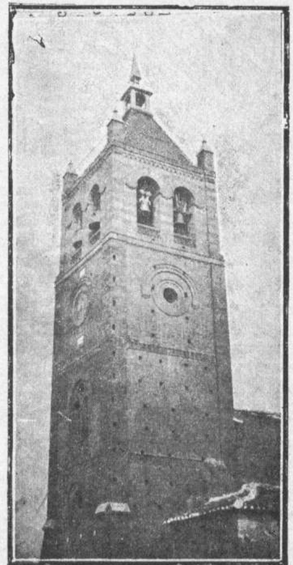
La torre de la Iglesia de Villaherreros
