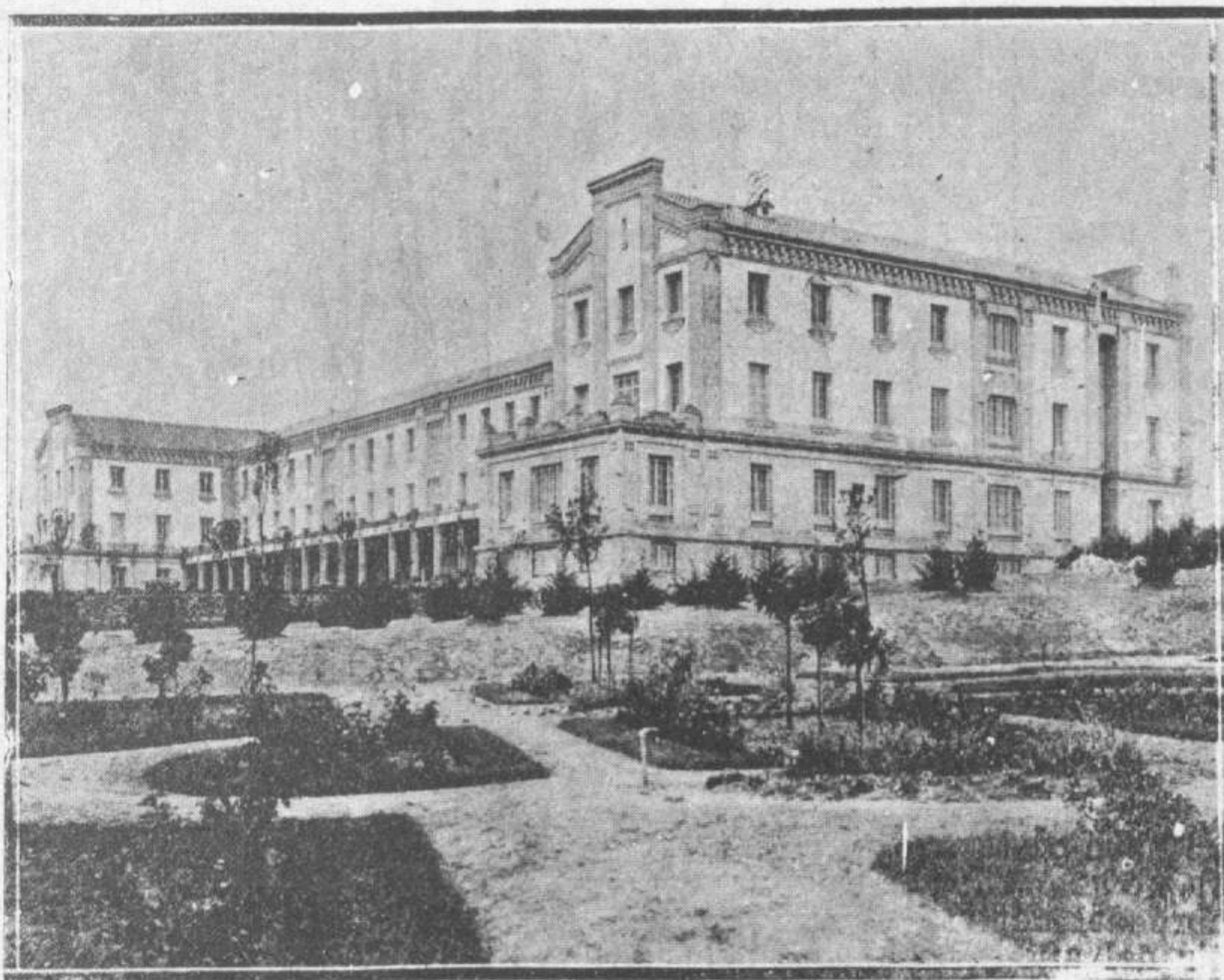
Fachada exterior del Pabellón de Pensionistas
