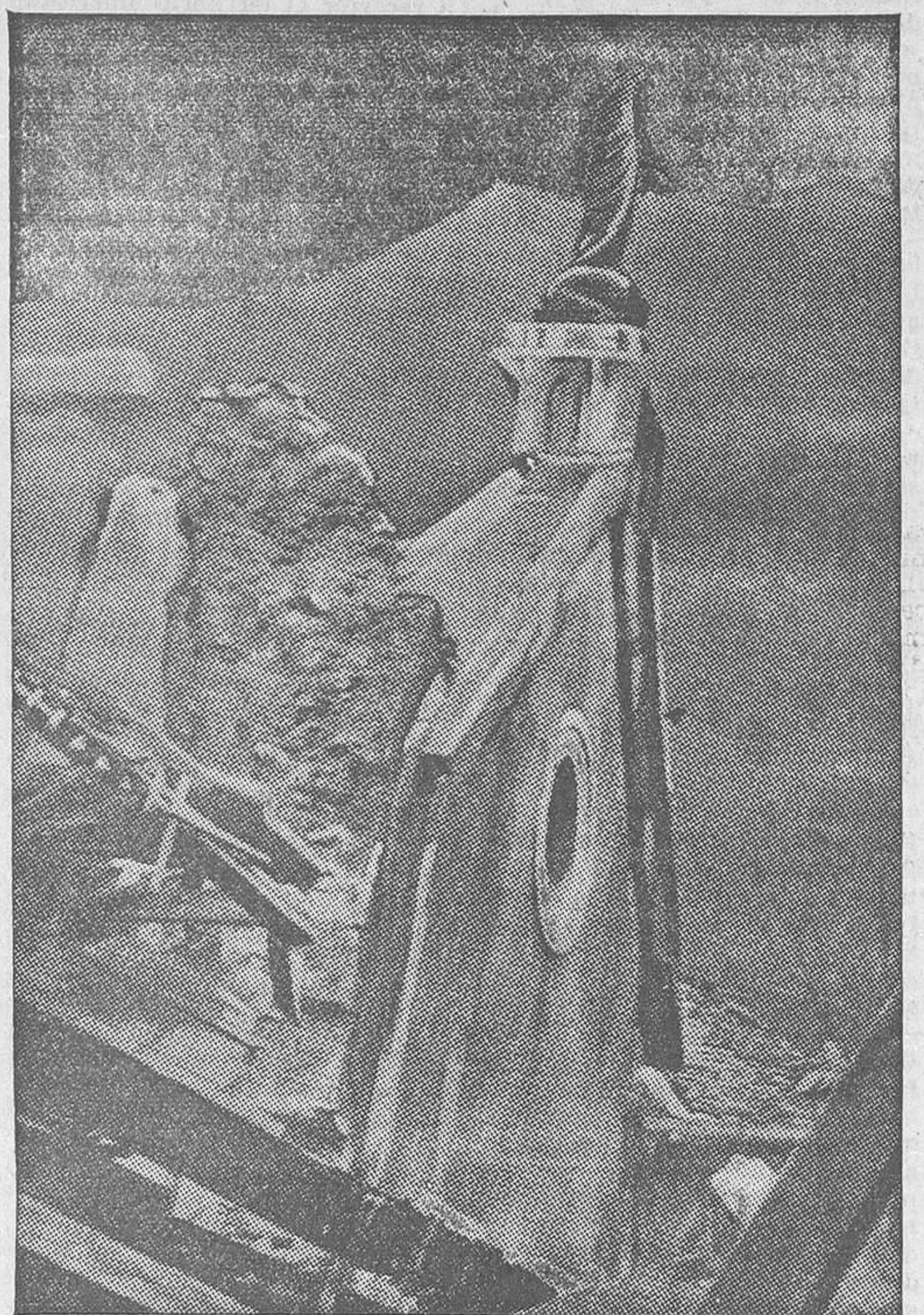
Hace dos días, en Grenoble (Francia), un desprendimiento de tierras hizo que una enorme masa de piedras cayese sobre la célebre destilería donde los padres cartujos fabrican el licor universalmente conocido. La destilería quedó destruida, y el edificio central comenzó a sufrir la presión de los materiales acumulados. Las pérdidas se calculan en 38 millones de francos, comprendida la maquinaria y las existencias de licores, que valen unos 10 millones.
