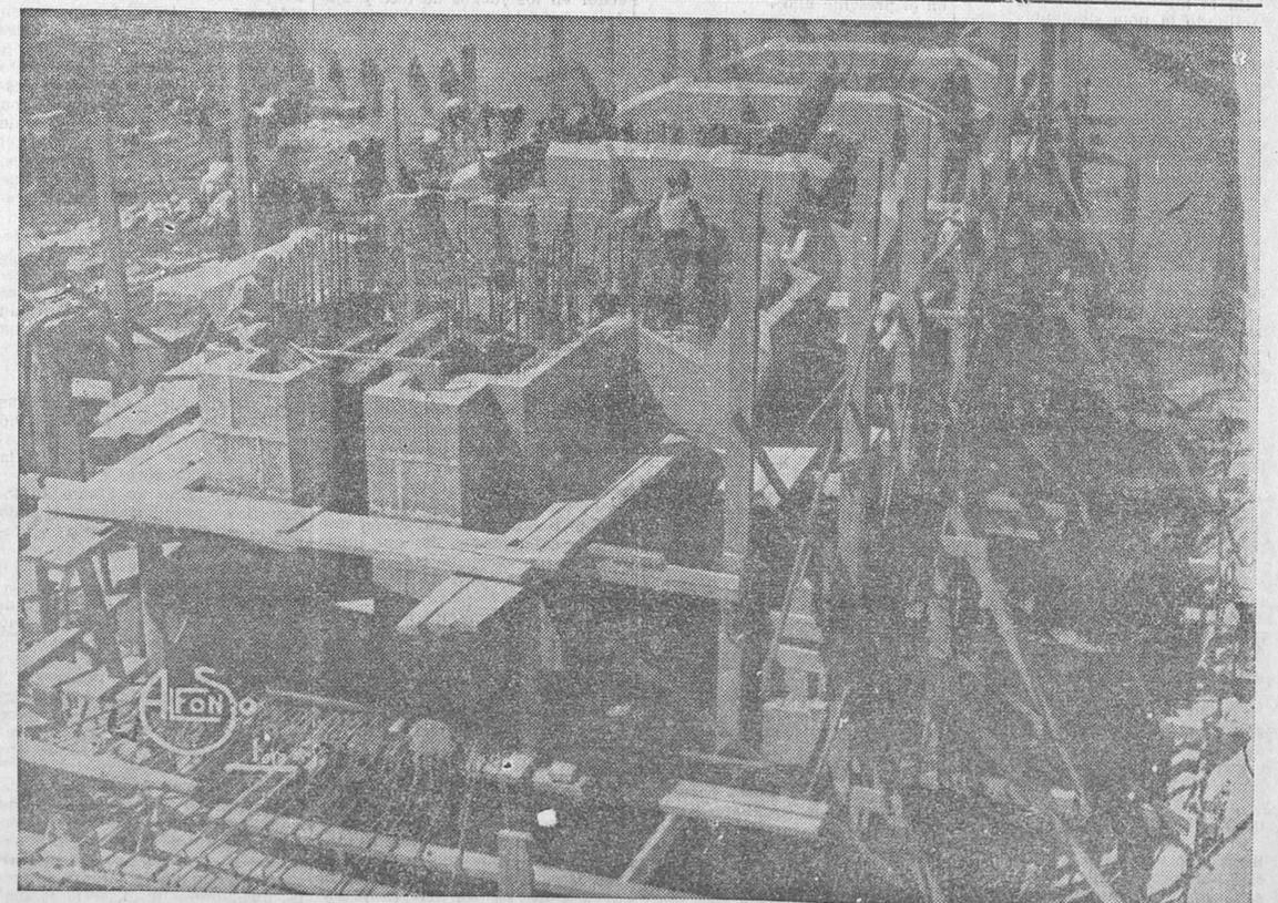
Un aspecto de las obras del nuevo viaducto, en el que se puede apreciar la colocación de uno de los grandes pilares en donde descansará uno de los arcos de la nueva obra (Fot. Alfonso.)
