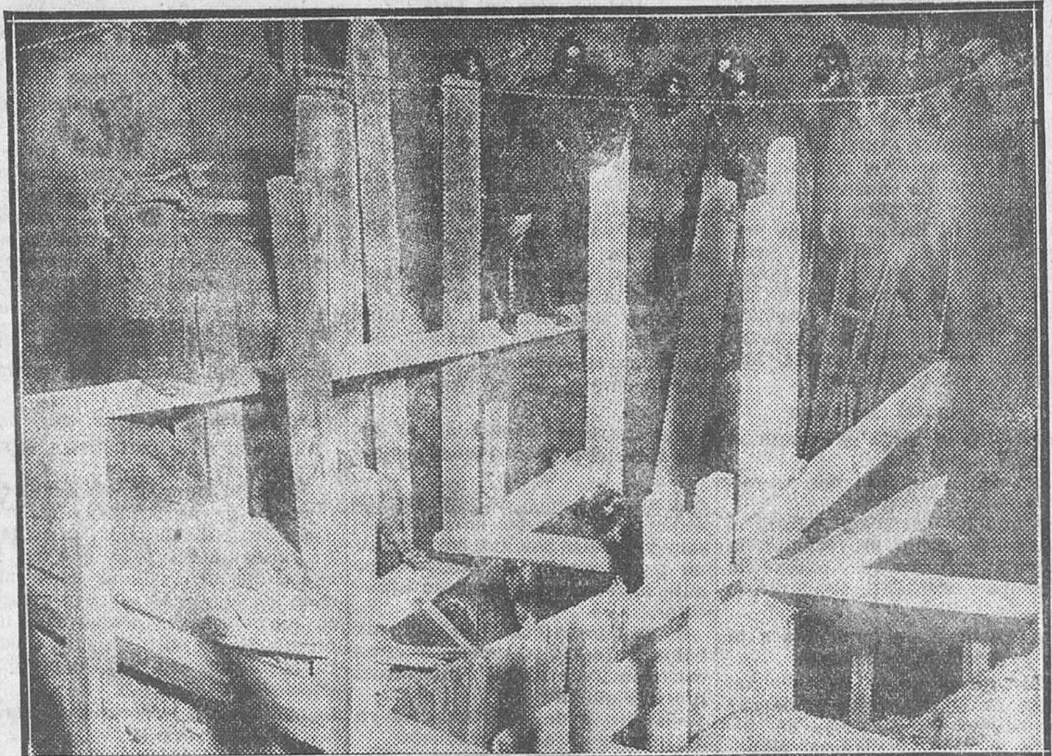
DEL DESPRENDIMIENTO DE TIERRAS DE AYER.—Los bomb eros en los trabajos de entibar las paredes de la zanja para extraer el cuerpo del obrero sepultado a consecuencia de un (Fot. Alfonso.) desprendimiento de tierras
