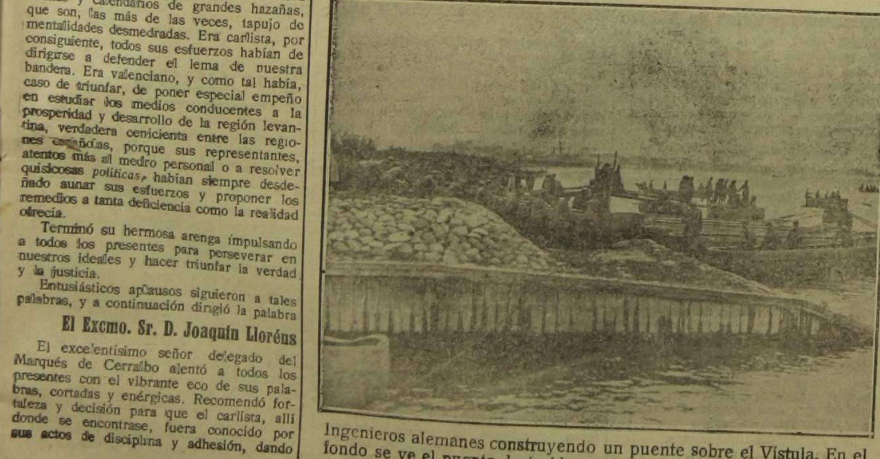
Ingenieros alemanes construyendo un puente sobre el Vistula. En el fondo se ve el puente destruido por los rusos entre Varsovia y Praga
