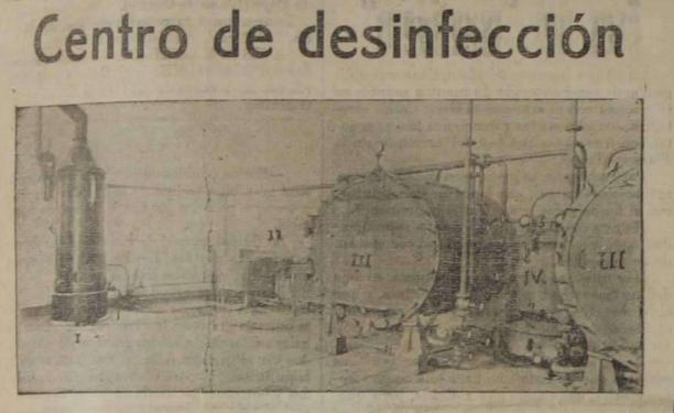
I. Caldera generadora de vapor.—II. Legidadoras.—III. Cámaras-estufas de desinfección por el formol en el vacío y por vapor a presión.—IV. Vaporizador de formol
