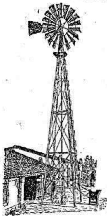
Molinos de Viento para elevar agua con aplicación de su fuerza motriz a otras industrias; puede además utilizarse como motor aplicando con transmisión sus energías a los usos adecuados que convengan.
