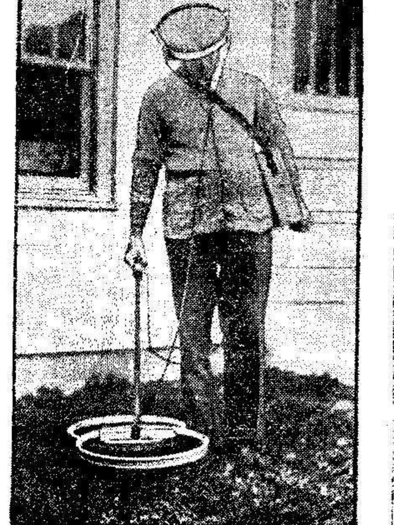
Se trata de un aparato de radio muy útil para buscar filones de mineral. Con la ayuda de este aparato, se pueden hallar los objetos de metal que se encuentran bajo tierra...
