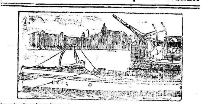
Proyector de un barco-bomba de gran potencia, montado sobre soportes como los cañones, y que es orientado por medio de dos cuadrantes metálicos de gran tamaño.
