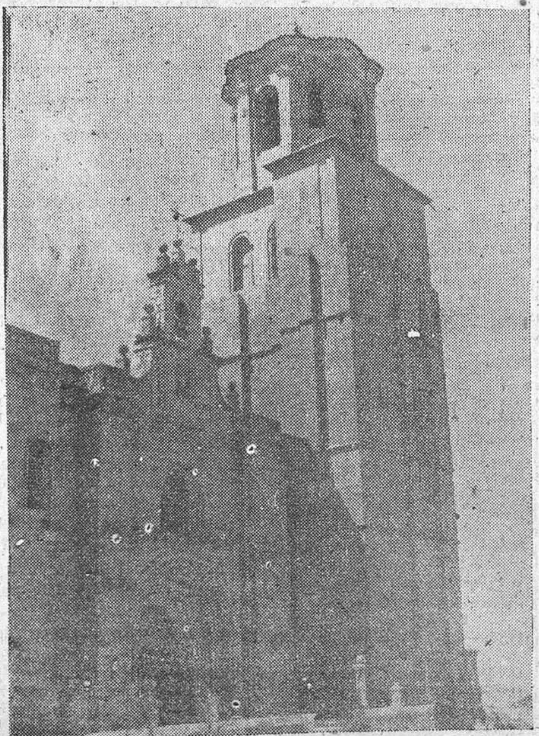
Toro.—Torre de Santa María la Mayor.
