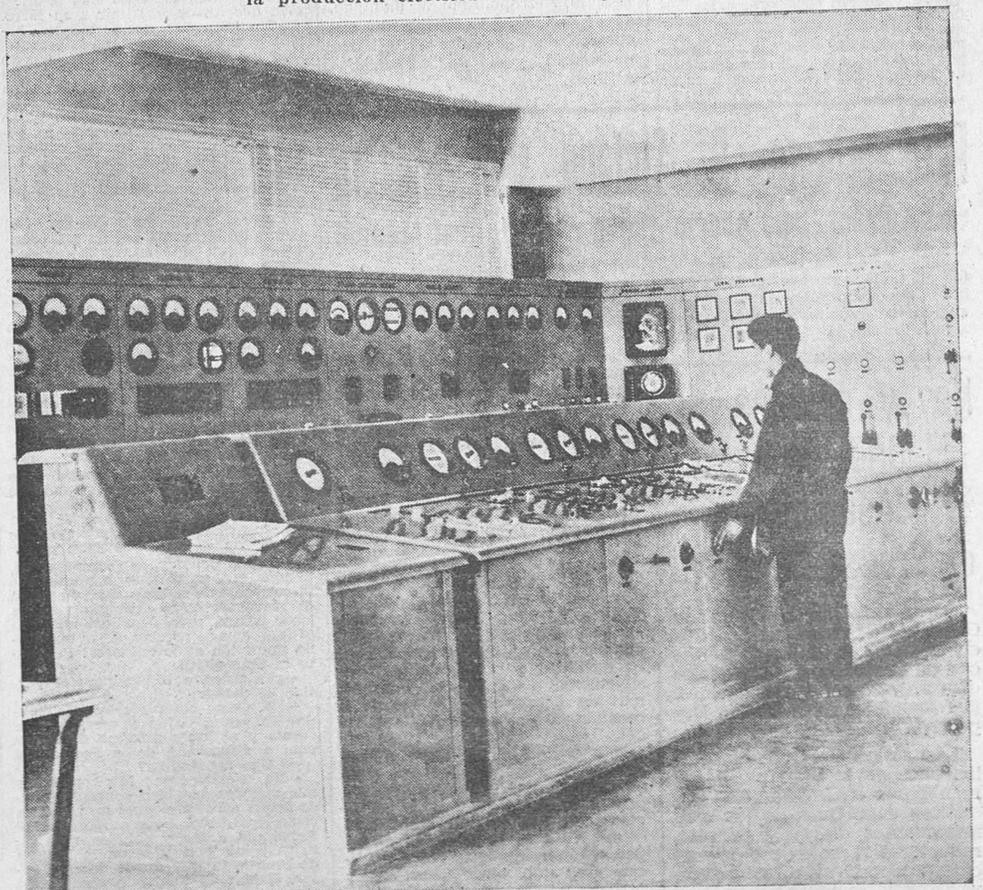
Sala de cuadro de mandos de la Central Hidroeléctrica de Moncabril. Un especialista maneja los botones para que la energía, a través de los hilos, dé luz o mueva alguna máquina.
