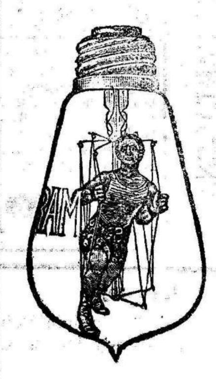
la lampara «OSRAM» se fabrica hoy con filamento de hilo estirado irrompible (último invento en la fabricación de lamparas metálicas), que la hace tan resistente como las antiguas de carbón.
