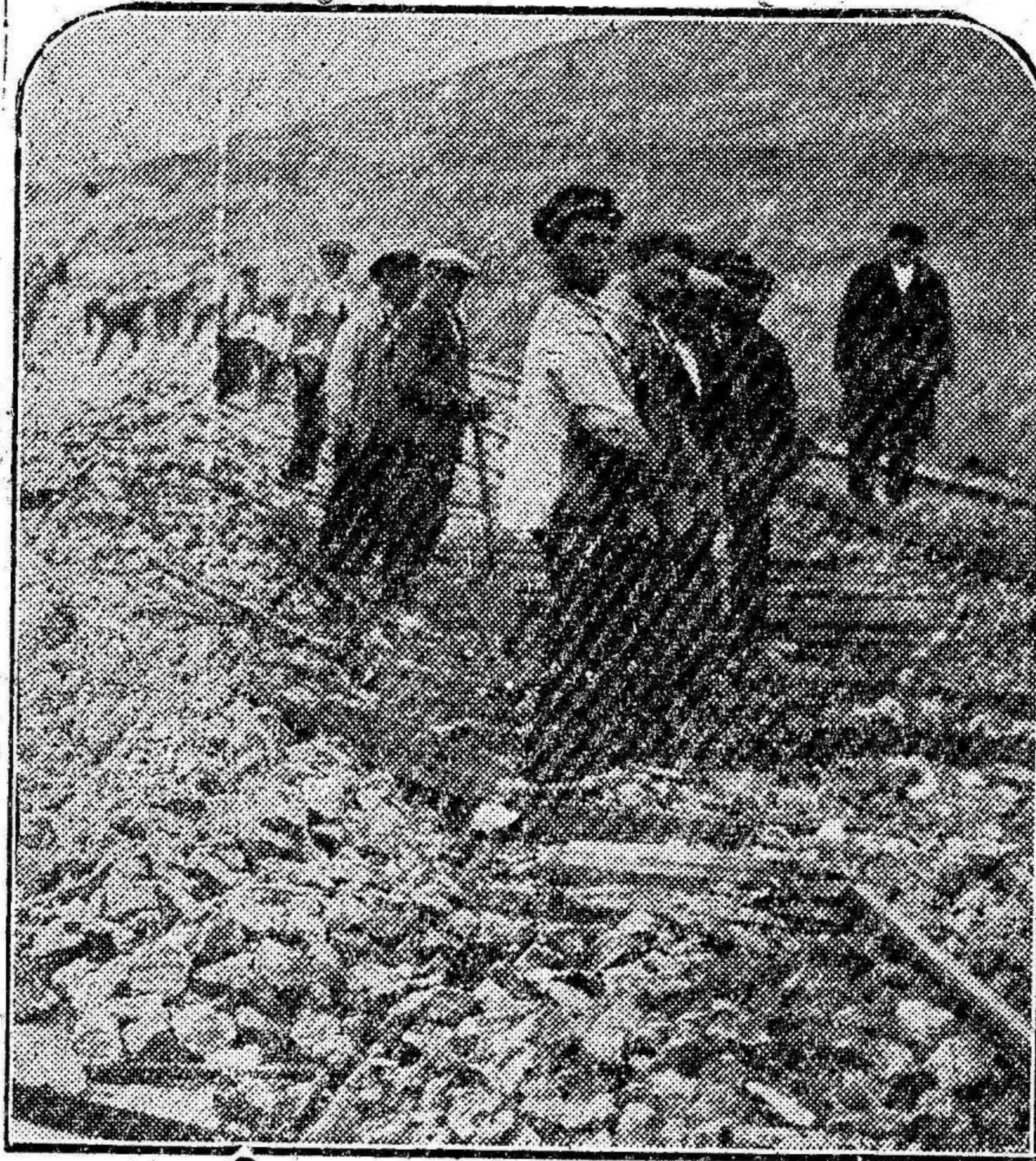
Brigadas de obreros reparando el trozo de vía donde ocurrió el accidente
