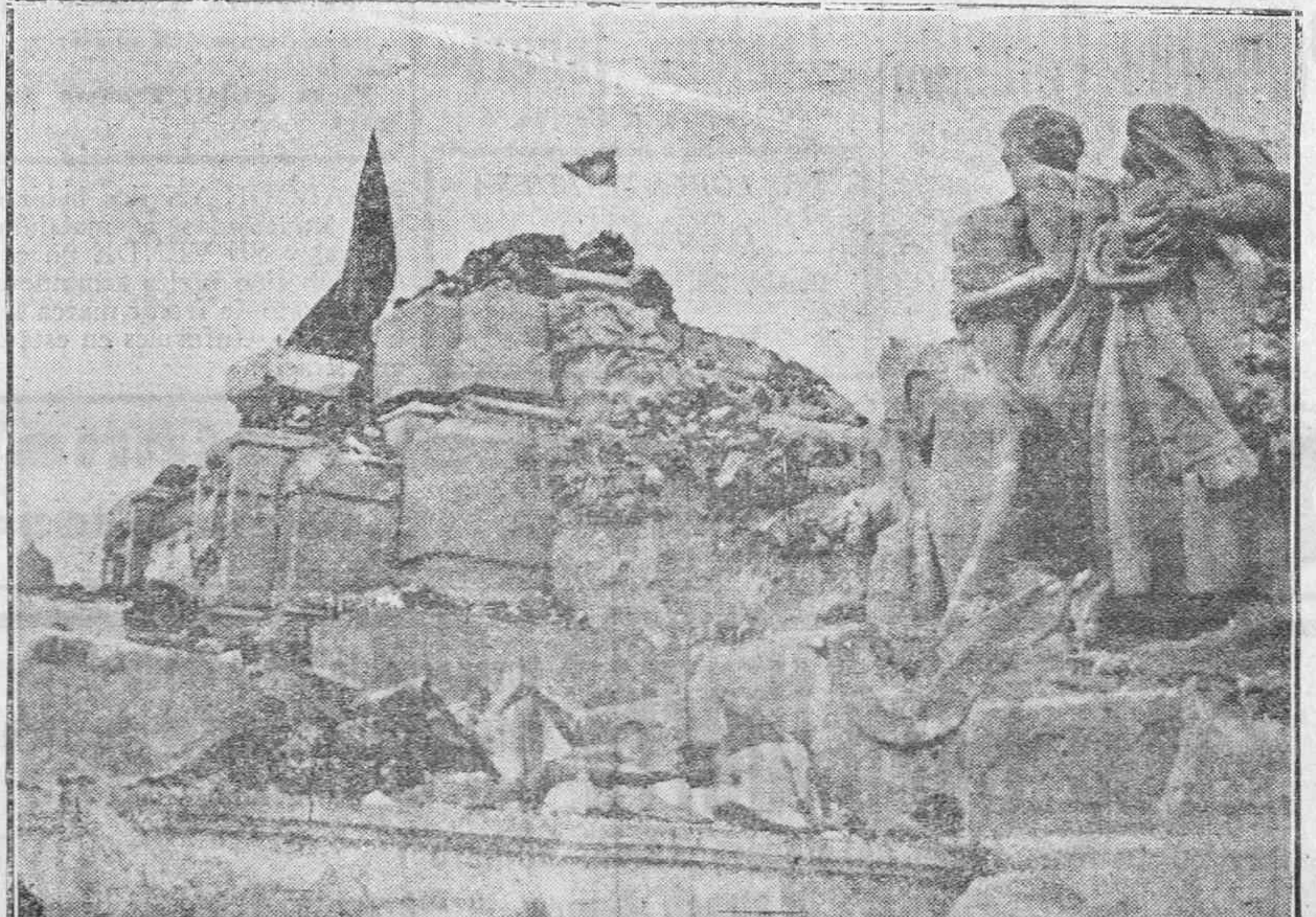
Cerro de los Angeles (Madrid).—Restos del Monumento nacional al Sagrado Corazón de Jesús de strozado salvajemente por los marxistas.
