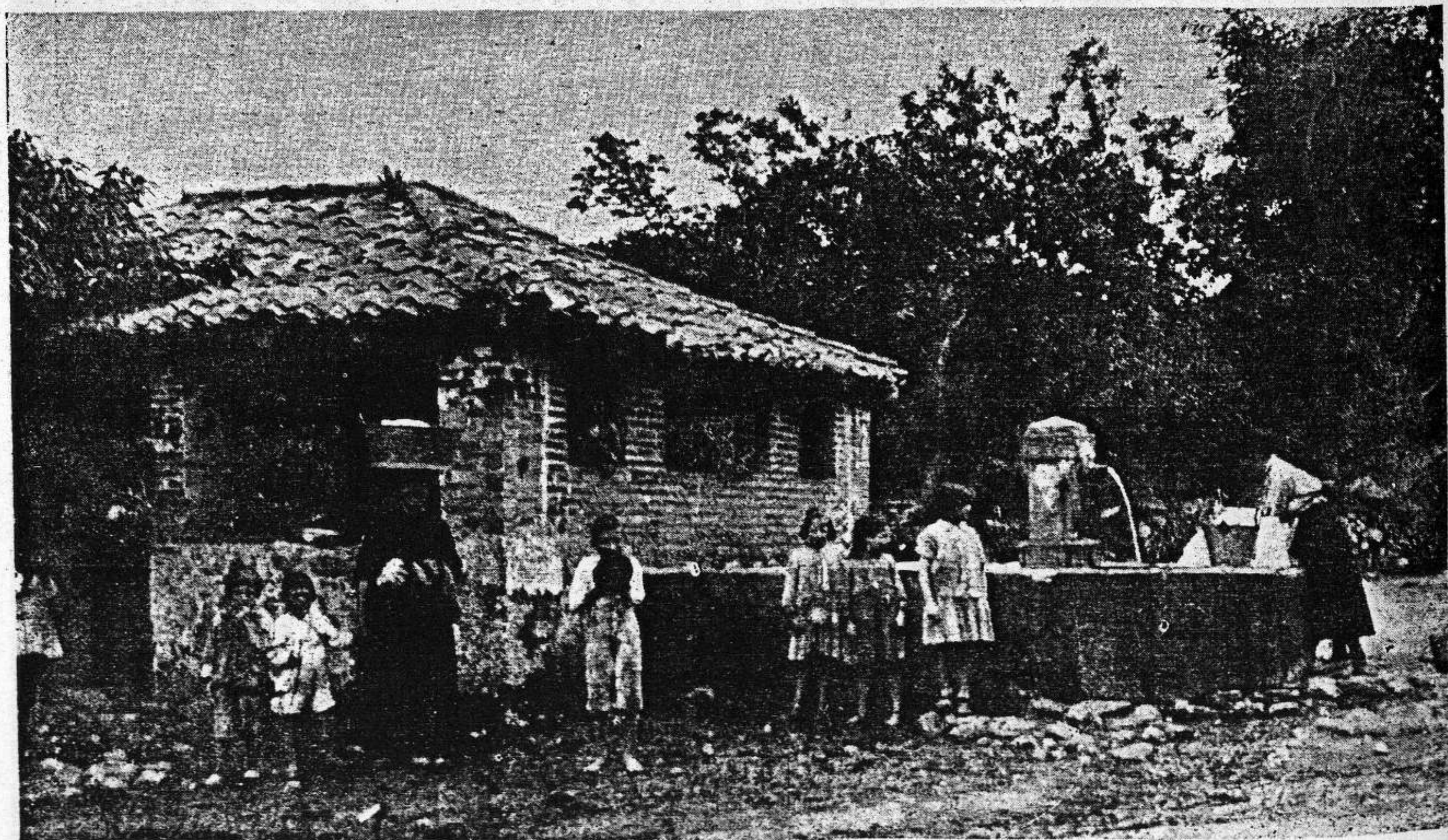
Fuente y lavadero procomunales en el mismo pueblo
