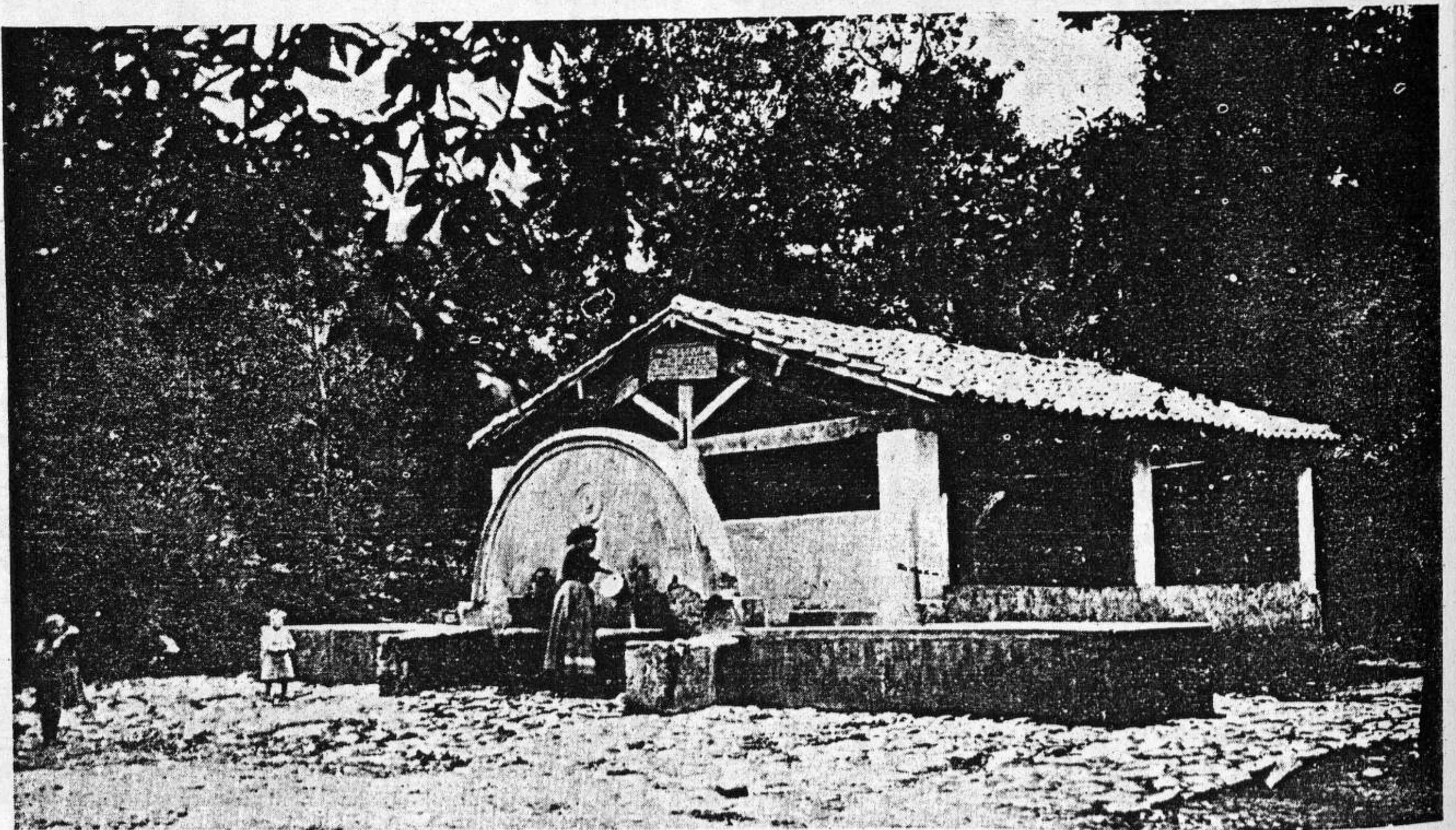
Lavadero y fuente de San Roque l'Acabal
