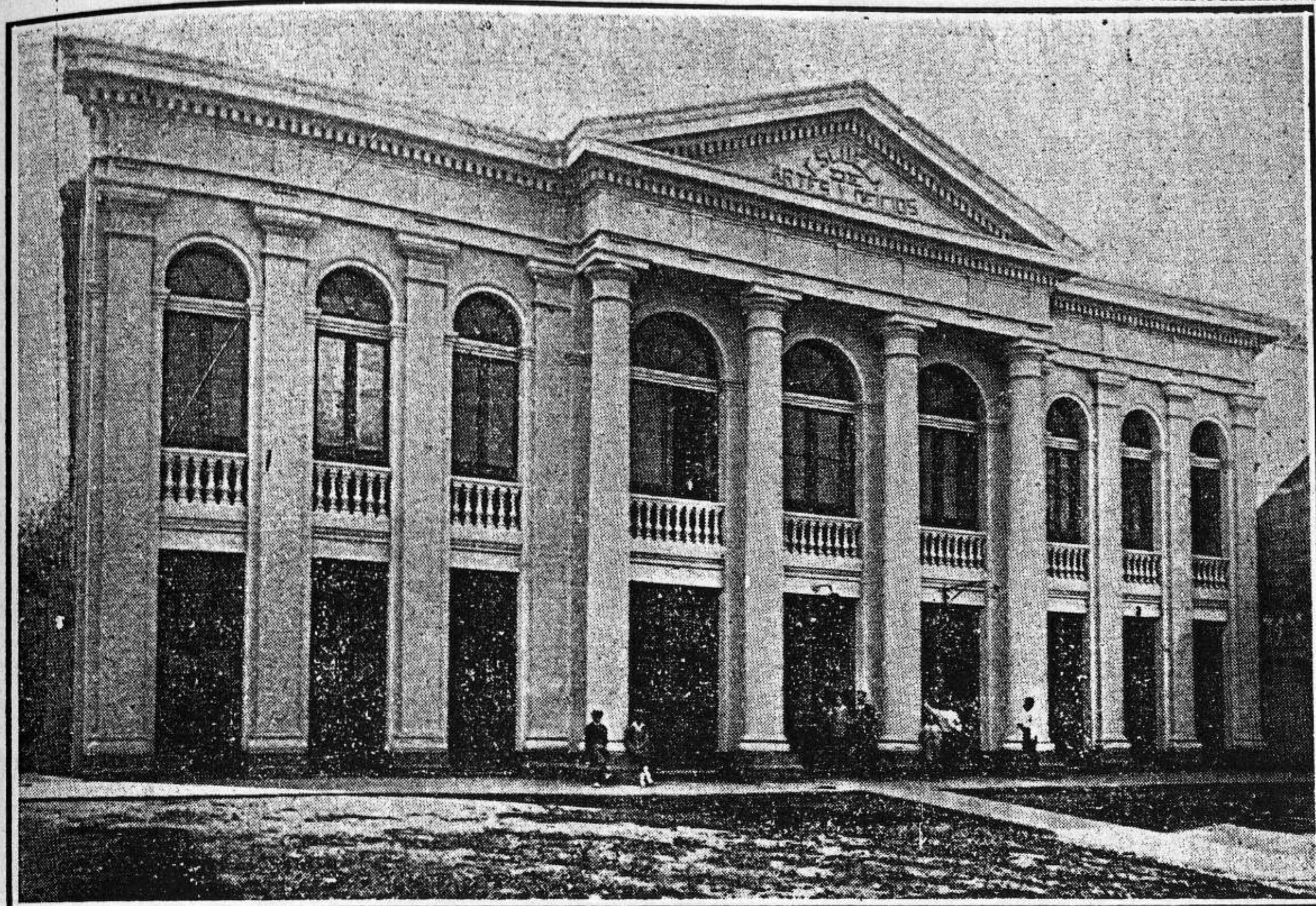
AVILES.—La Escuela de Artes y Oficios, cuya fachada fué recientemente reconstruida, como prueba esta fotografía (Fot. M. G. Alonso)
