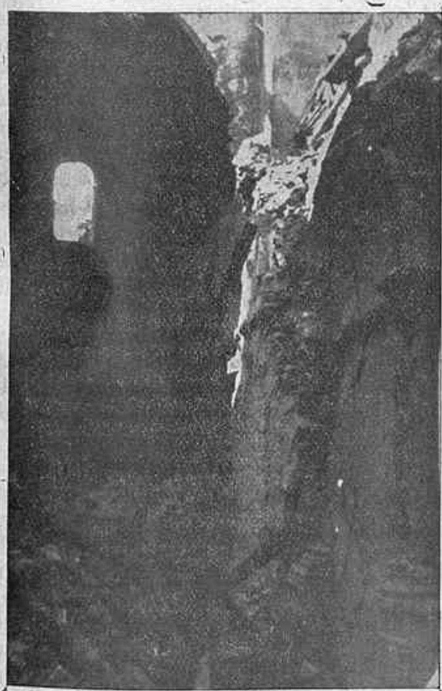
Parte de la Cámara Santa y Claustro, en donde se advierten los terribles destrozos causados por la dinamita
