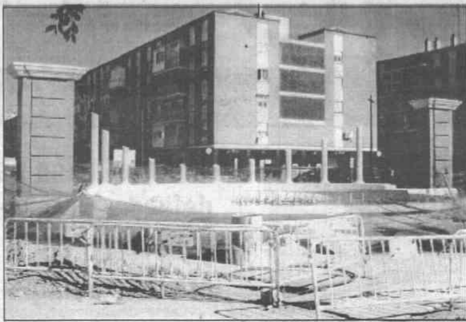
Aspecto de las obras de la fuente que se está instalando en la Plaza de Alpañés.
