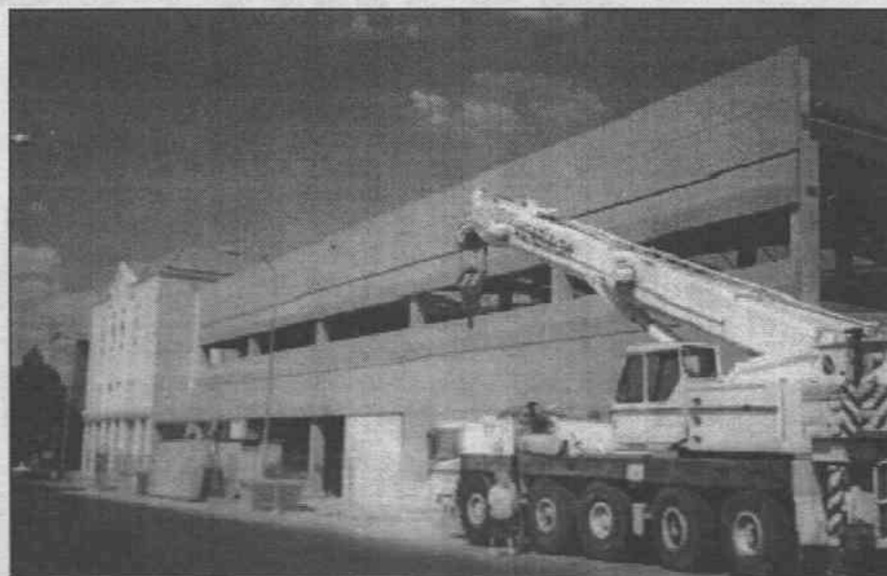
Fachada del edificio donde estarán los Multicines.
