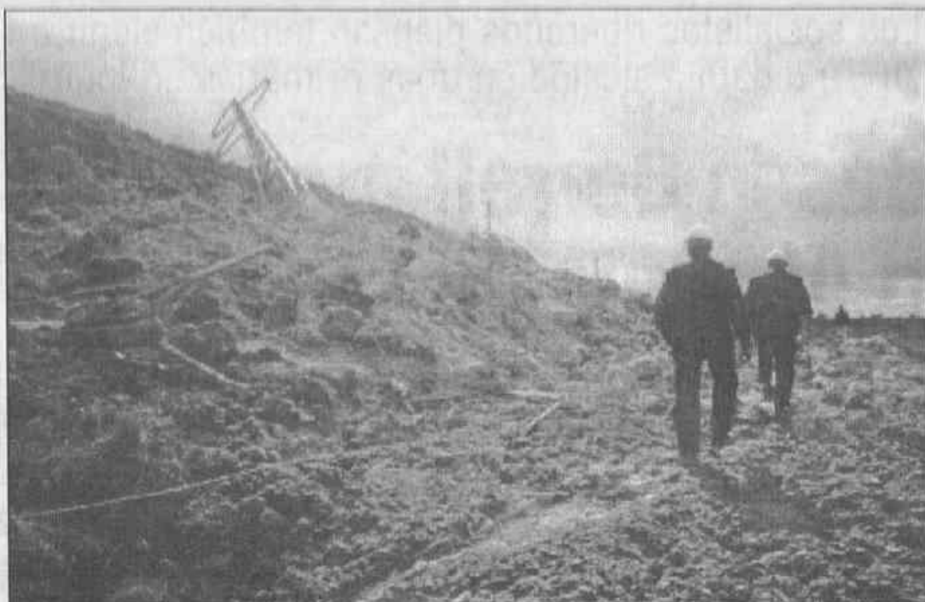
La mole de tierra se desplazó ladera abajo hasta llegar al caz de las aves que atraviesa la zona, afectando en su recorrido a varias columnas de transporte eléctrico. Según Unión Fenosa el movimiento arrancó una columna de 17 metros y otras de 10 metros.
