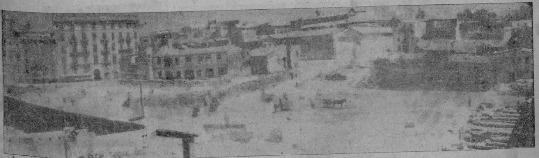
Continúan con gran actividad las obras de derribo y explanación en el solar que ha de ocupar el Mercado del Óliver. La fotografía está tomada desde la parte de San Antonio de Viana; el edificio alto a la izquierda es el que forma esquina con la calle de Capuchinos y el paso que se ve hacia el centro es donde estaban el edificio de la Fundación Mallorquina y colindantes Foto Ferrer
