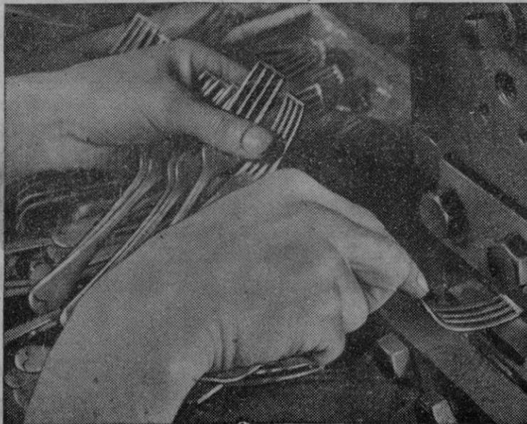
Arriba: Cucharas y tenedores troquelados en una plancha de alpaca. — Abajo: Corte de la tira de metal que une los extremos de las púas de los tenedores, después de la curvatura del tenedor.
