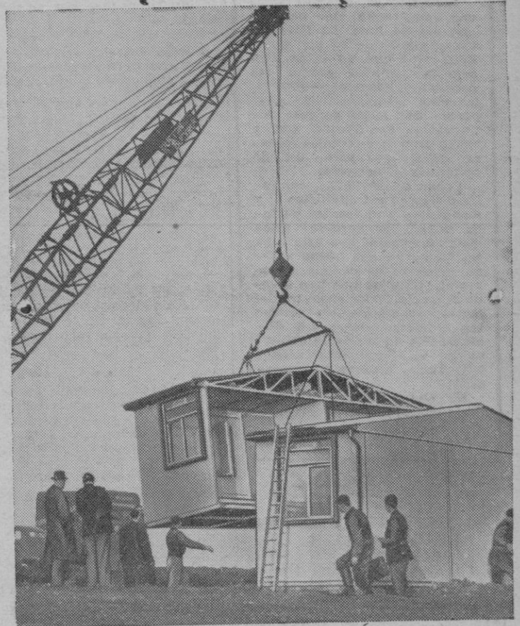
La producción de casas prefabricadas de aluminio toma un ritmo cada vez mayor en la Gran Bretaña. Grandes gruas móviles les transportan al lugar de su emplazamiento donde son montadas rápidamente
