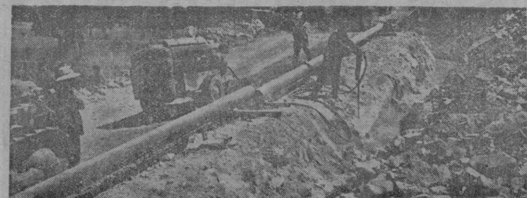
Están ya casi terminados los trabajos del alcoducto Rota Zaragoza, de 800 kilómetros de longitud. Hace catorce meses se inició la obra que será inaugurada uno de estos días. Un esfuerzo notable de técnicos y operarios. El alcoducto será uno de los más largos de Europa
