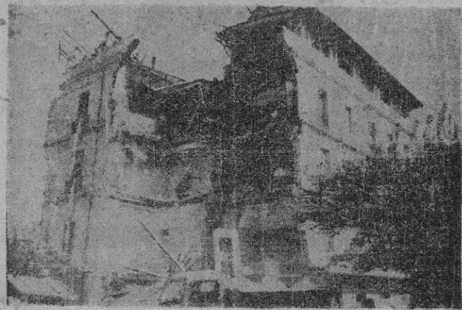
Edificio destruido en el reciente terremoto de Orleansville.
