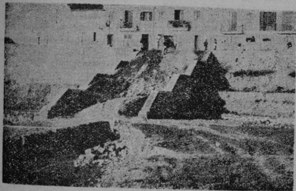
Se han construido muros de contención para salvar el desnivel del terreno, formándose una amplia escalinata
