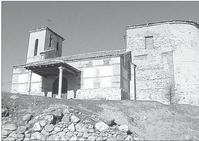
Las obras refuerzan el muro de contención de la iglesia, en un precario estado. / EL ADELANTADO
